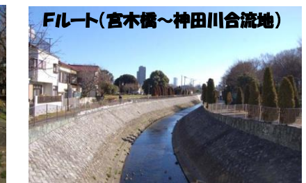
住宅地等に囲まれ、川底がコンクリートに覆われ、水辺の植物はほとんど見られない
