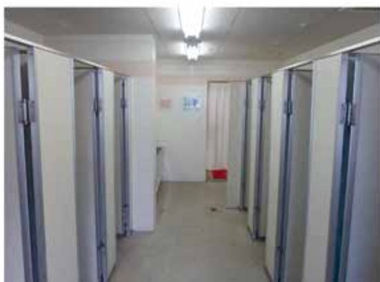
女子トイレ 改修前
