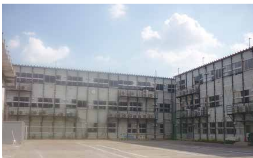
改築工事中の仮設校舎の設置例
