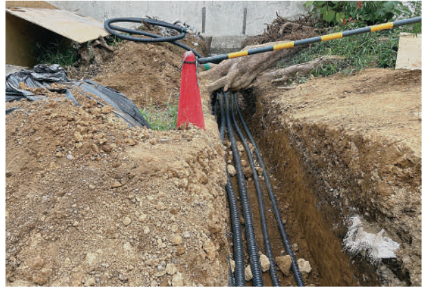
2 引込盤付近の掘削
