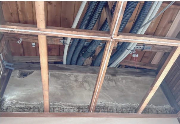
3 別棟トイレからの幹線配管状況
