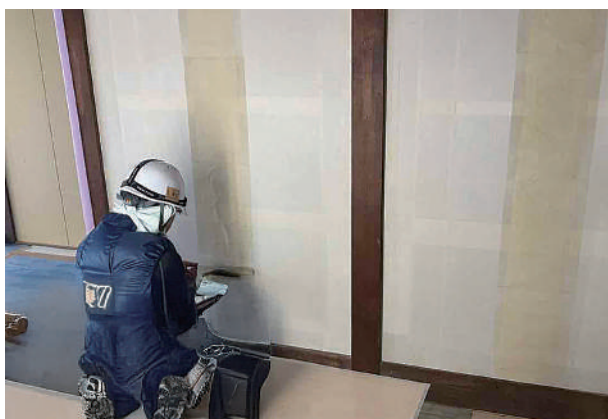
5 下張り（逃げしろ）施工状況
