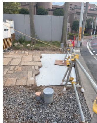
2 正門前東側板石下地施工状況
