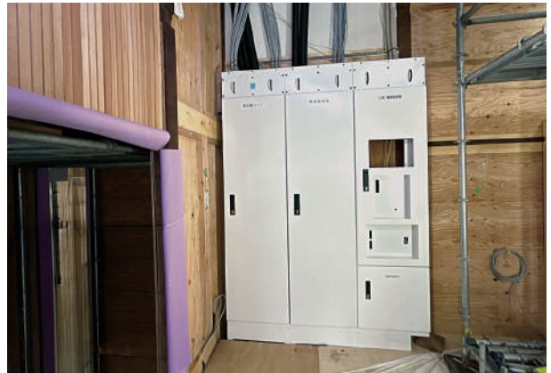
6 事務室 屋内電気盤据付状況
