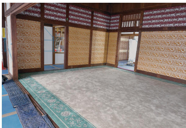
3 客間絨毯敷込完了
