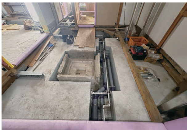
11 別棟次の間床下配管状況
