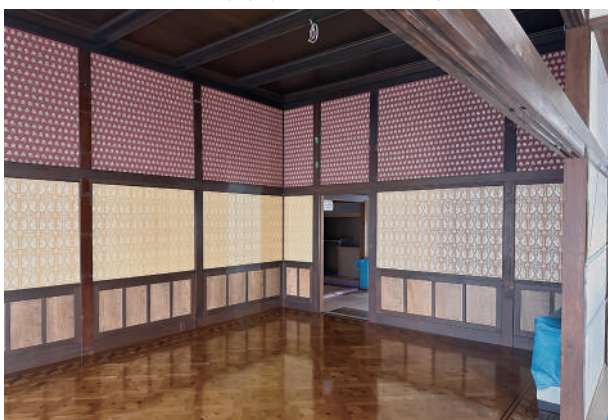
5 寄木施工完了
