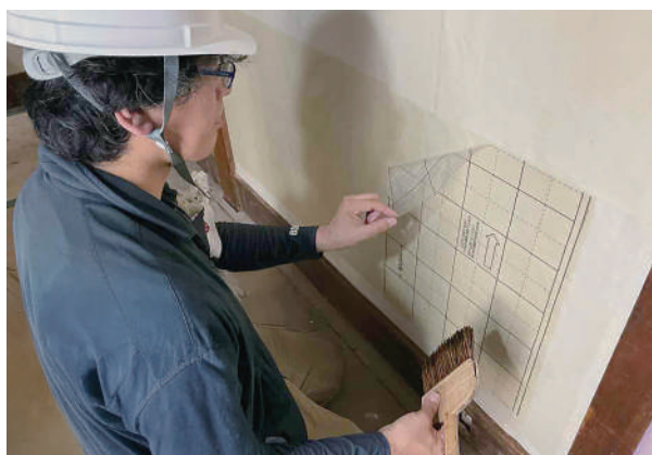
6 下張り（清ベタ）施工状況
