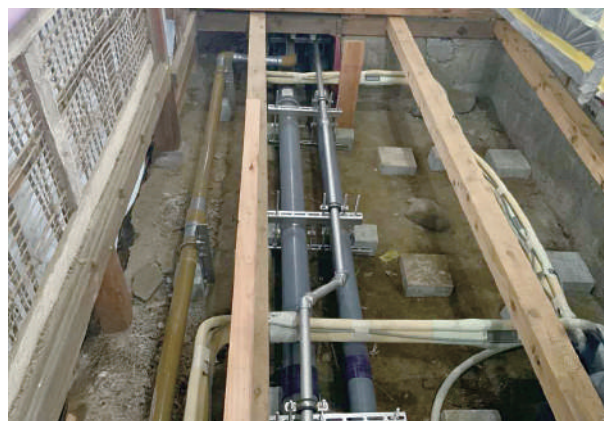
12 別棟蔵前床下からの配管状況工事記録写真
