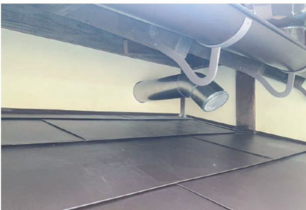
23 別棟台所 換気工事ダクト施工状況
