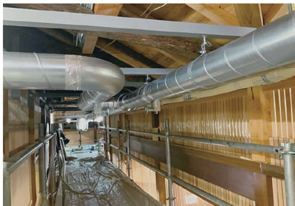
16 天井内ダクト配管状況
