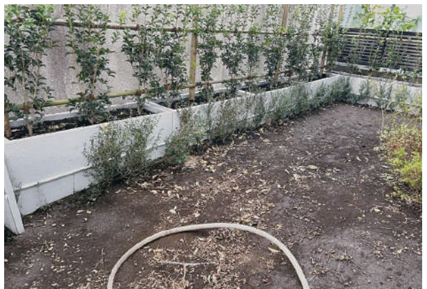
8 植栽柵側面の配管状況
