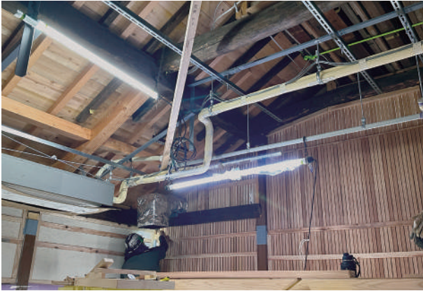
17 事務室吊り金物
