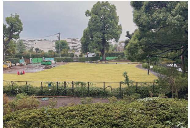
6 南側遊び場の芝張り状況
