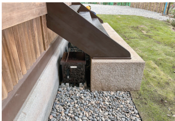
9 広縁南側木階下 屋外電気盤設置状況
