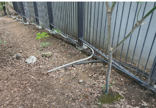
7 外周柵沿いの配管状況 外部フェンス配管(施工後)
