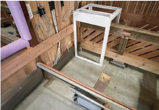
5 事務室 屋内電気盤架台設置状況
