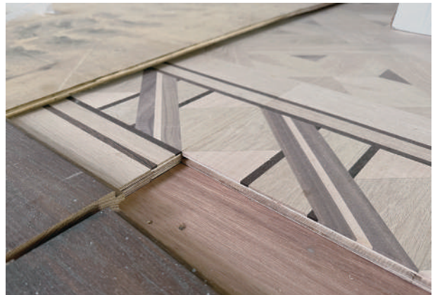
2 寄木施工状況
