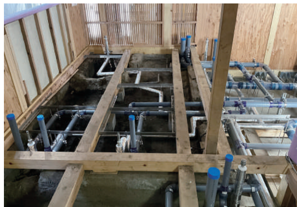
14 女性用トイレ 遺構上の配管状況
