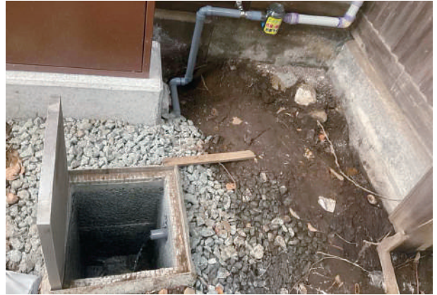
18 エアコンからのドレーン排水接続状況
