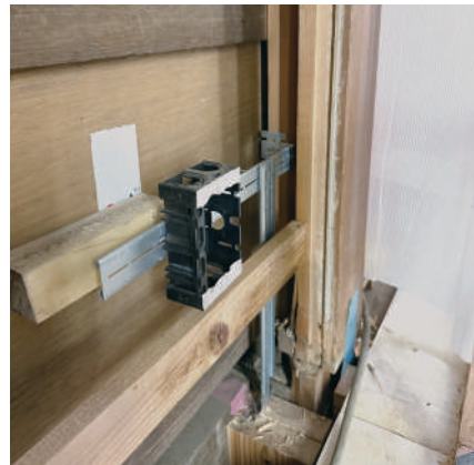
4 コンセントボックス固定状況
