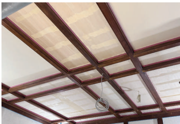
9 応接室天井龍画下地施工状況
