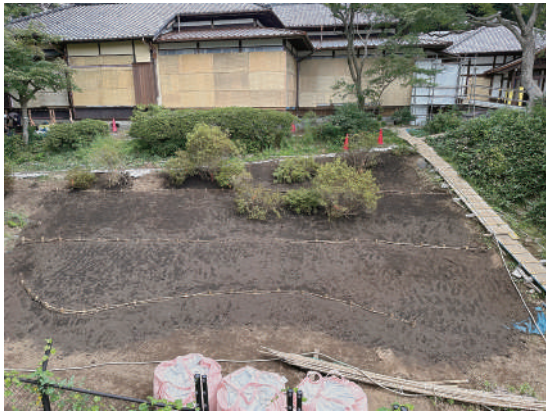
3 南側斜面しがら柵設置
