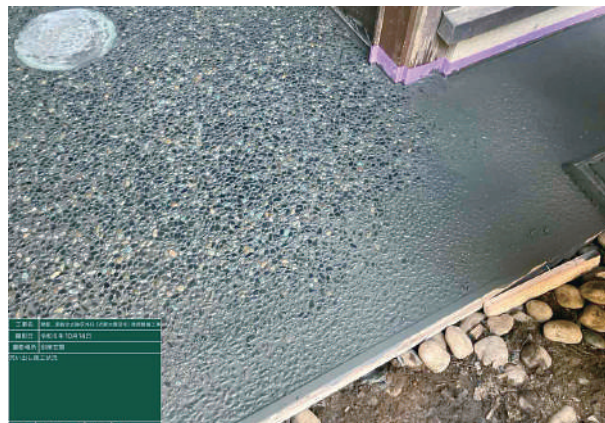
12 左官工事 洗い出し仕上げ
