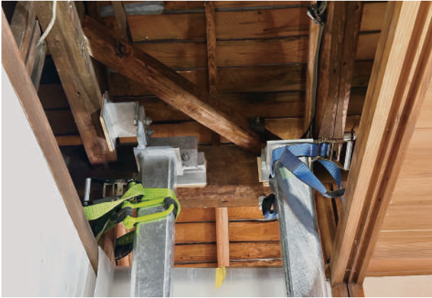
9 別棟次の間鉄骨 軸部との接合状況
