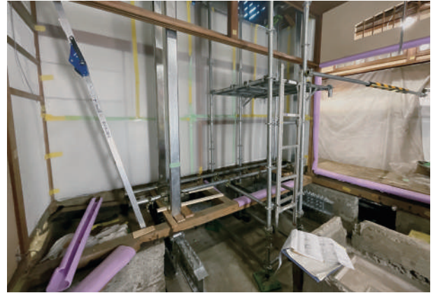
10 別棟次の間鉄骨 材建方状況
