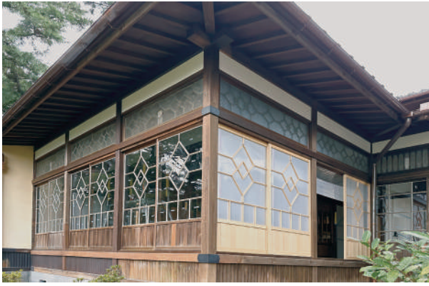
11 食堂広縁新規建具設置状況
