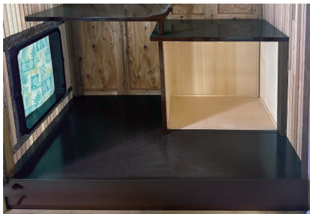
4 居間床脇 漆塗り調度設置状況
