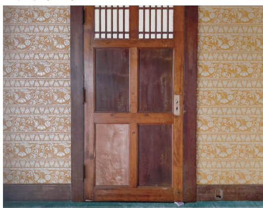
1 客間建具鏡板補修状況
