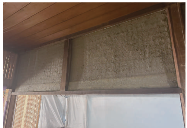
10 別棟蔵前竹木舞壁施工状況
