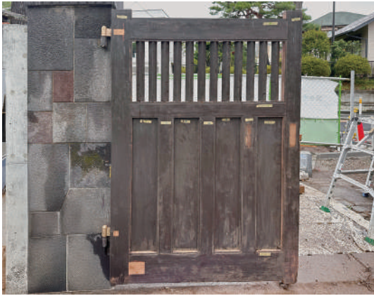
3 正門建具補修状況
