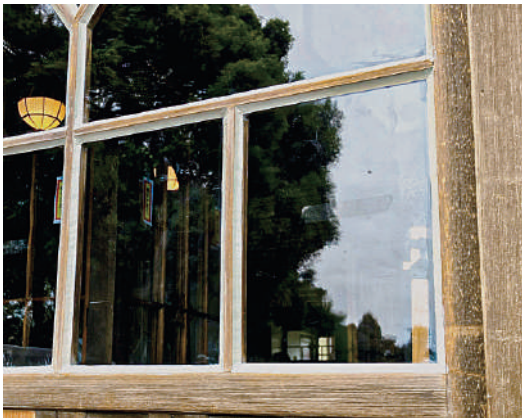
5 建具ガラスシーリング施工状況
