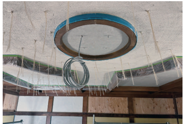
6 客間天井ひげこ設置状況
