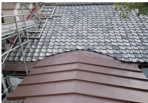
12 別棟屋根施工完了
