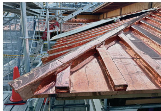
15 下屋銅板葺 隅部
