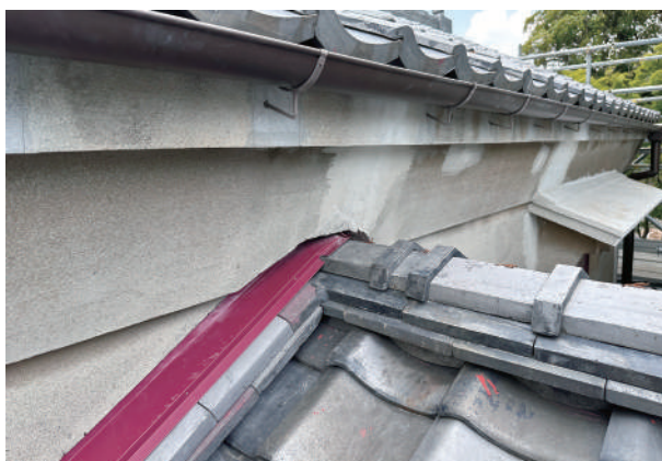
22 蔵の樋と別棟雨押え板金
