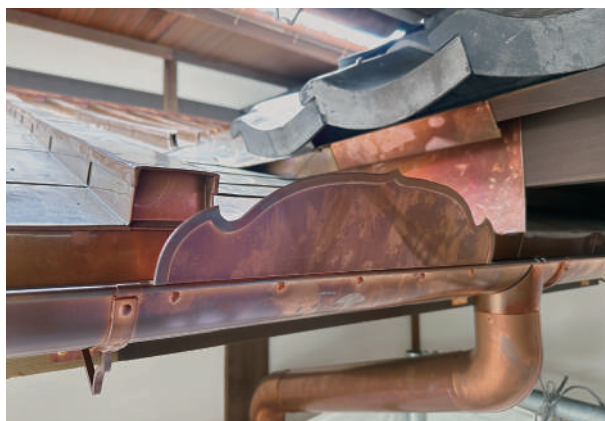
18 次ノ間北側 瓦と下屋との谷部
