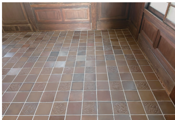
9 敷瓦施工完了
