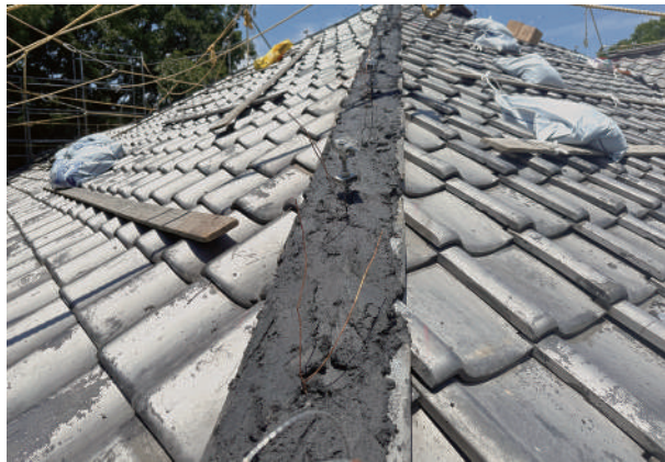
3 荻窪棟棟積補修と棟補強金物
