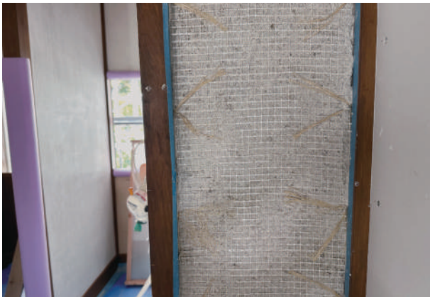
3 砂漆喰壁ひげこ伏せ込み状況
