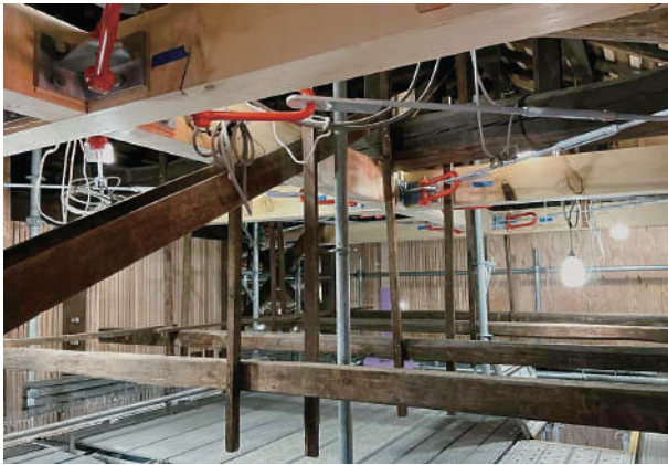
1 鉄骨工事 寝室・食堂天井内ブレース
