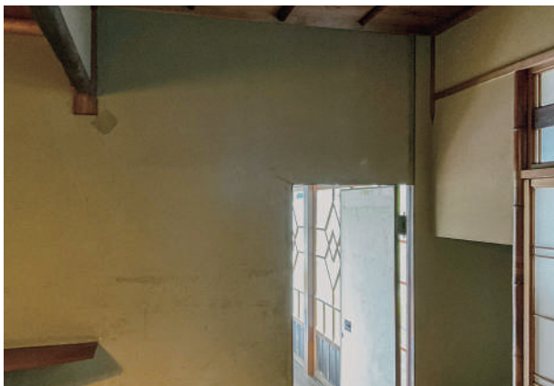
11 書斎聚楽壁補修後（右側が補修後）
