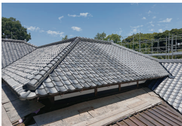
11 屋根瓦完了 古材瓦と新規瓦の区分状況
