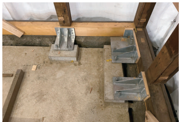
8 土台プレート補強状況
