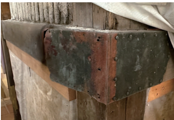
3 寝室北西隅の既存長押金物
