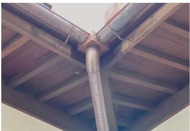
21 入り隅部の樋受け金物
