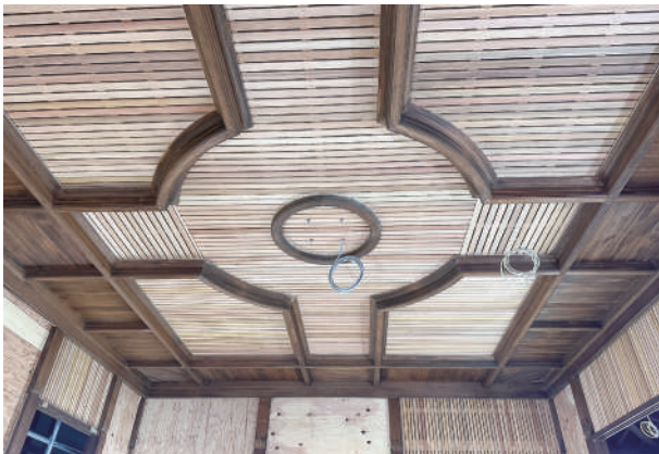
5 客間天井木摺施工状況
