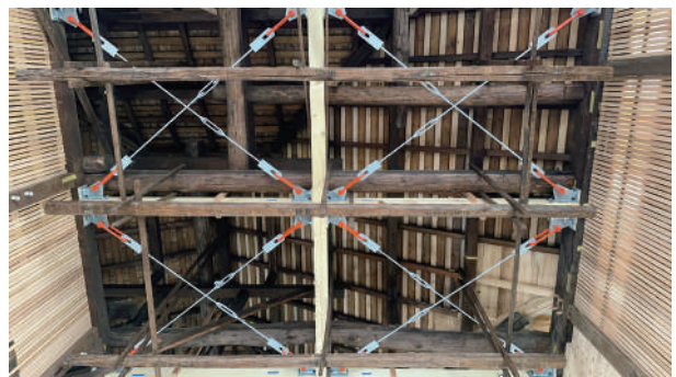
6 食堂上部ブレース施工状況
