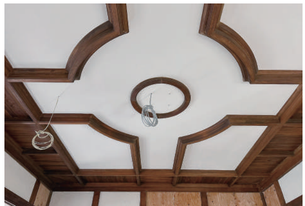
8 客間天井漆喰完了状況
