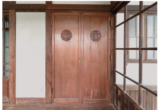
6 次ノ間南側扉取付状況
