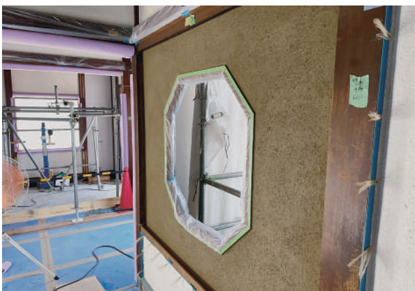
9 廊下1八角窓周辺竹小舞壁施工状況
