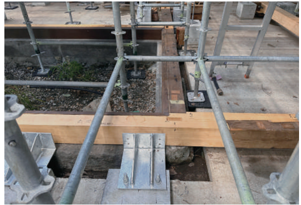
2 延石内側の耐圧板に設置したプレートを経た土台固定状況
