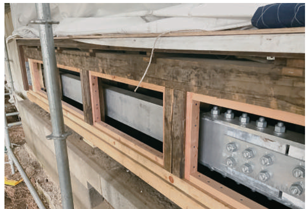
4 書斎縁側床下の補強鉄骨
