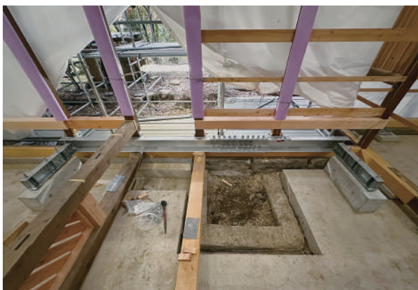
7 来客用手洗部分の鉄骨補強
