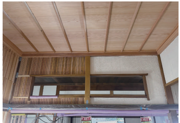
2 縦木摺と砂漆喰施工状況
