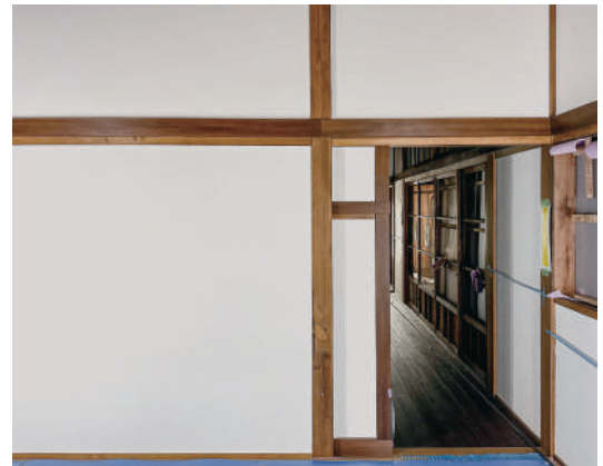
4 漆喰仕上げ壁（廊下2西側）
