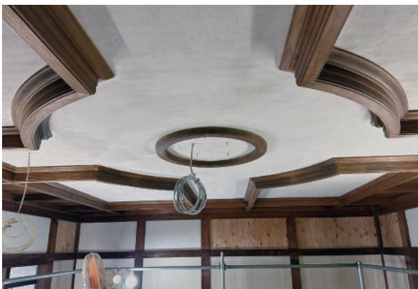
7 客間天井砂漆喰施工状況
