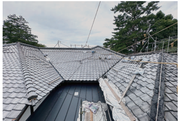
4 屋根瓦施工状況 (北側玄関付近)
