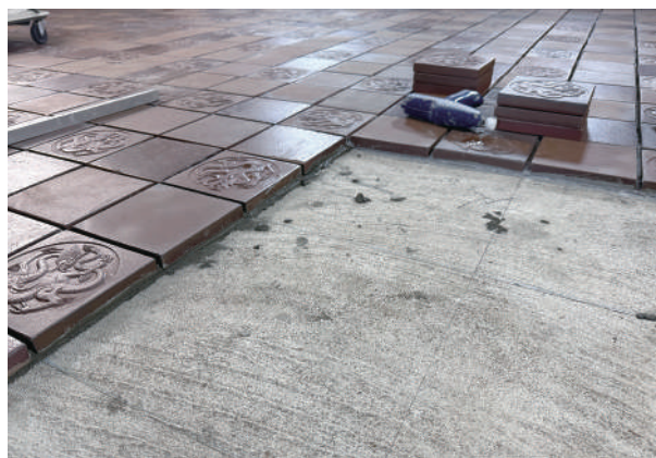
8 敷瓦施工状況
