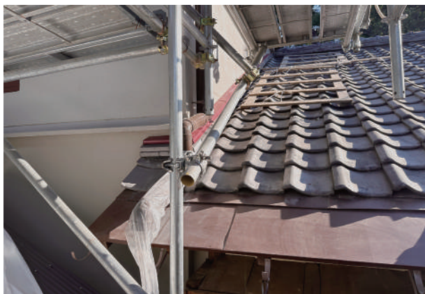
13 別棟東側と蔵の接合部分
