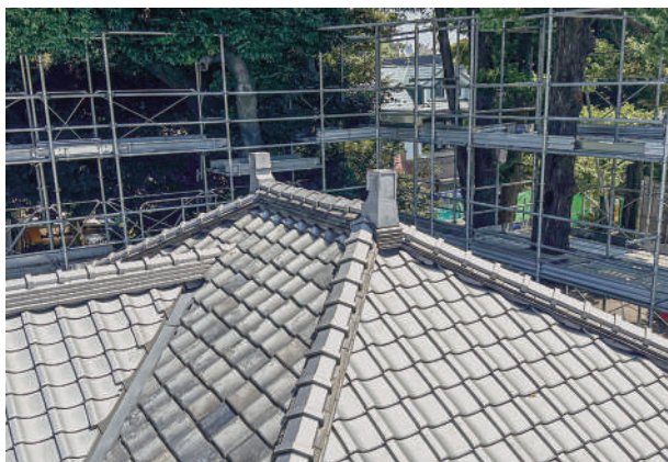
9 応接室屋根と鴟尾取付状況
