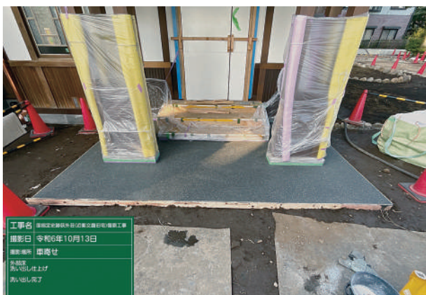
13 左官工事 洗い出し仕上げ
