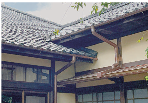
20 寝室北側谷部の屋根と樋
