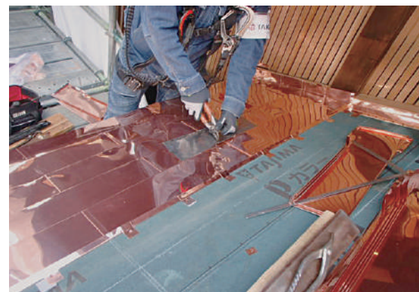
16 車寄横葺施工状況
