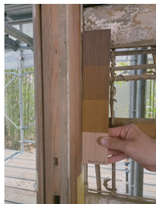
2 別棟柱色合わせ検討状況
