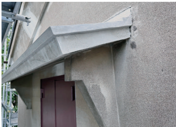
5 蔵外壁クラック補修と庇塗膜防水施工状況
