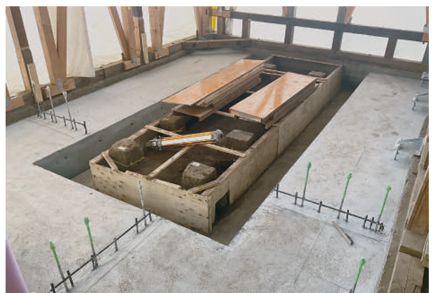
8 食堂内基礎コンクリート
