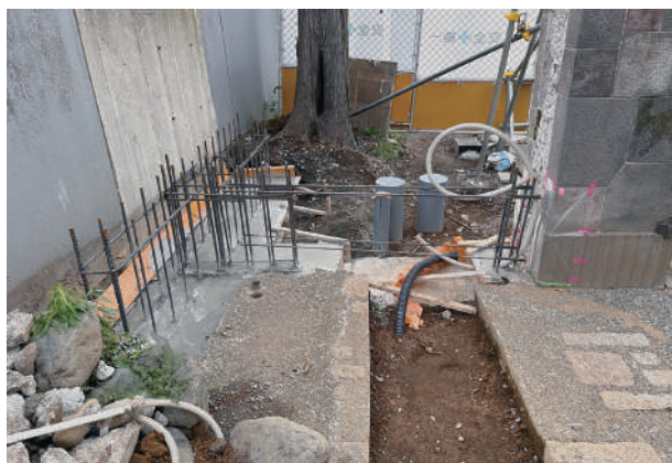
19 正門袖壁配筋状況
