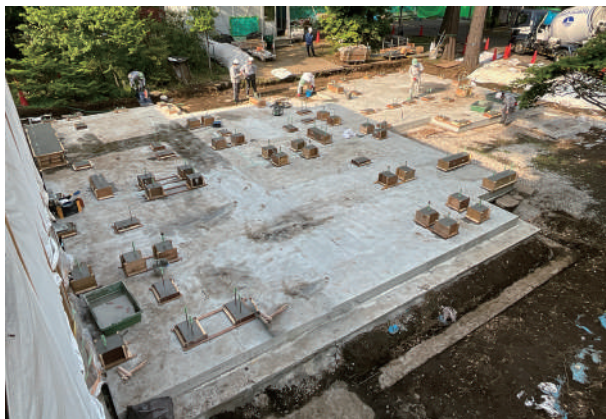
11 巣鴨棟 耐圧板上の基礎立ち上がり施工状況
