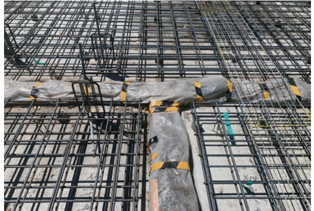
2 遺構突出部の保護と配筋
