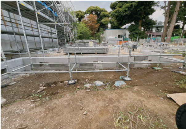
7 延石据付完了
