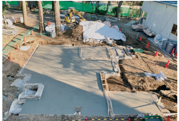
4 巣鴨棟耐圧板コンクリート基礎打設後
