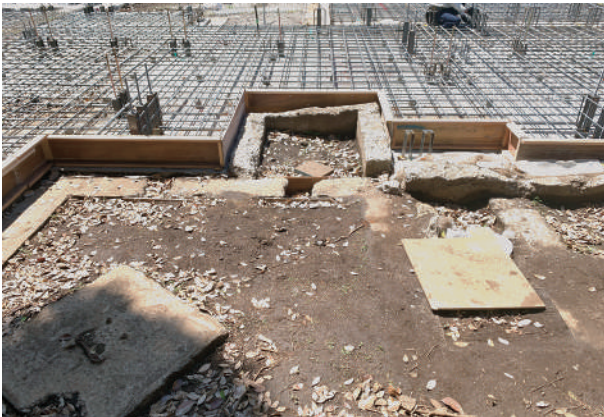
3 基礎遺構内側への耐圧板施工状況
