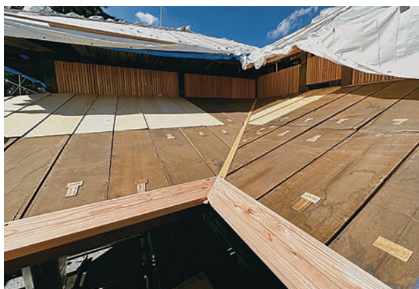
13 下屋化粧野地板施工状況
