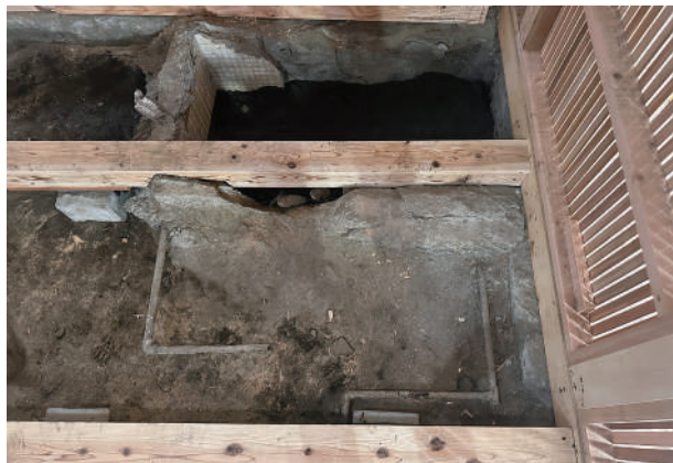
15 創建時浴槽遺構と床組
