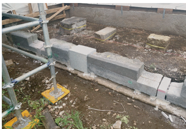
5 古材と新規材の延石据付状況
