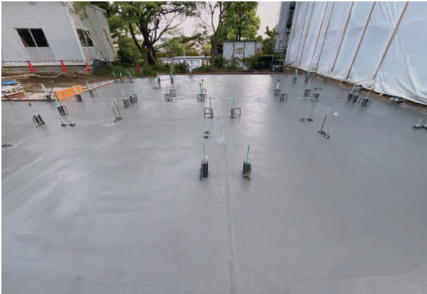
5 耐圧板設置と遺構突出部の伸縮目地
