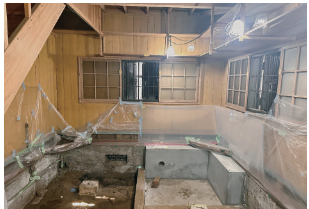
12 蔵の補強基礎施工状況
