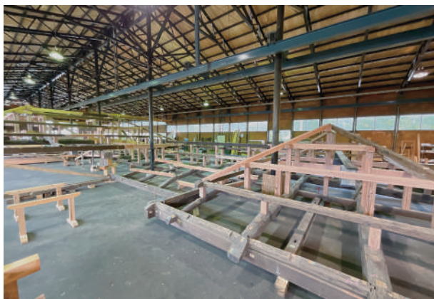
3 福井工場での仮組玄関棟
