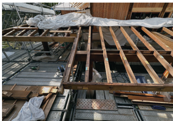
12 下屋垂木施工状況
