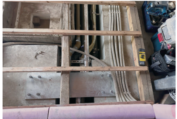
10 別棟 設備配管スリーブ設置に伴う補強プレート
