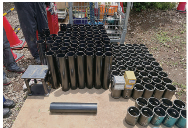
2 地盤改良用小口径杭
