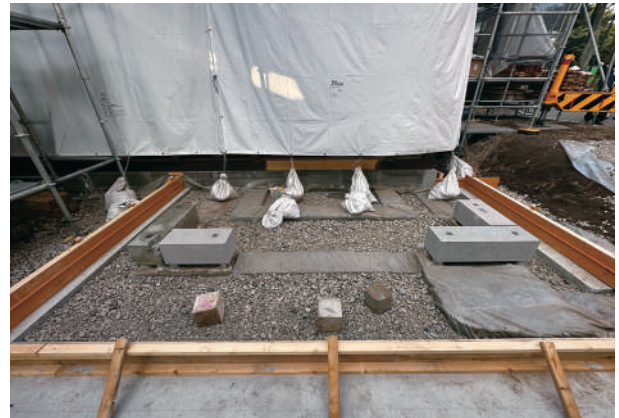
10 車寄石据付状況
