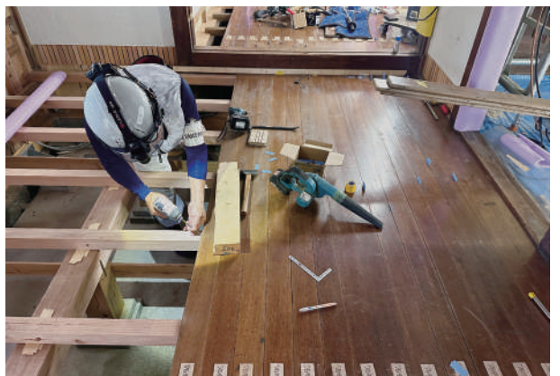
26 床板施工状況
