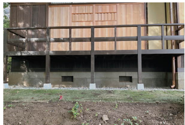
30 寝室濡れ縁施工完了
