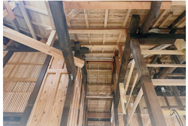
20 巢鴨棟と荻窪棟接続部
