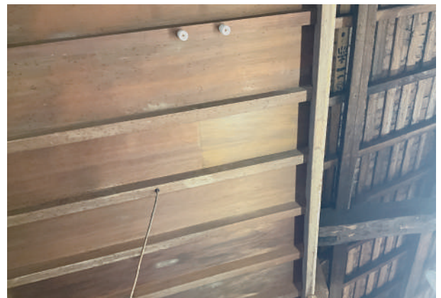
24 廊下3化粧天井補修状況
