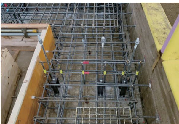
7 食堂内既存基礎への差筋アンカー施工状況
