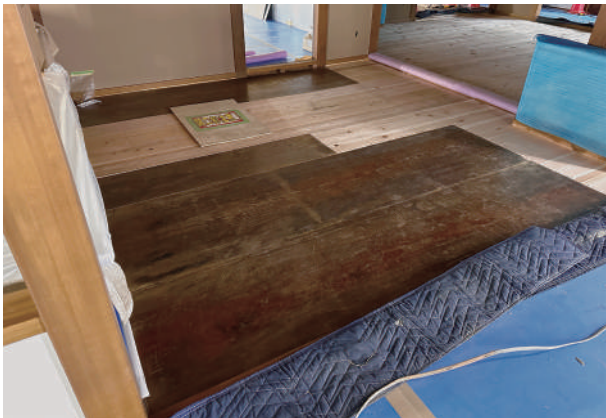
27 茶ノ間荒床に設置した近衛文磨住居期の玄関床板
