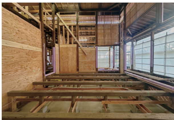
17 客間軸部施工状況
