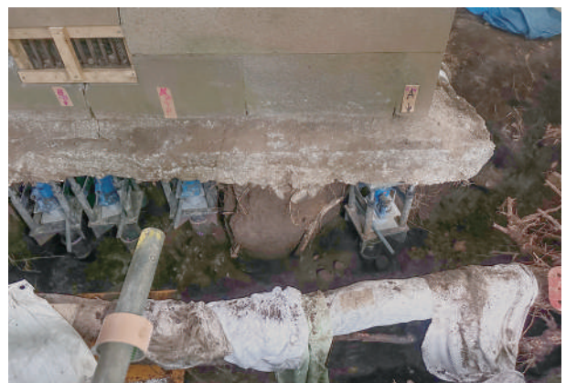
4 杭のジャッキアップ状況
