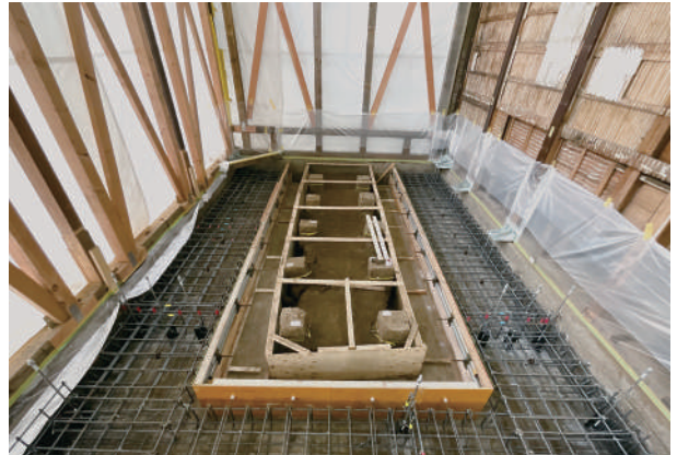
6 食堂内基礎配筋状況
