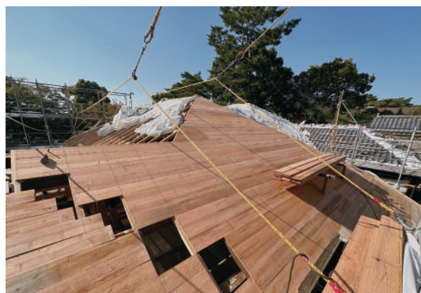
10 巣鴨棟野地板施工状況
