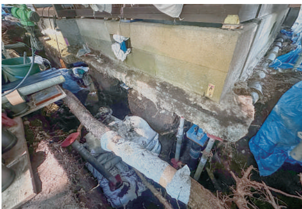
3 寝室西側掘削状況
