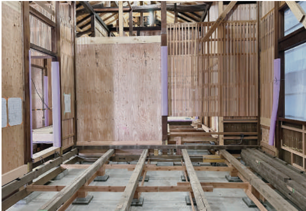
19 応接室軸部完了
