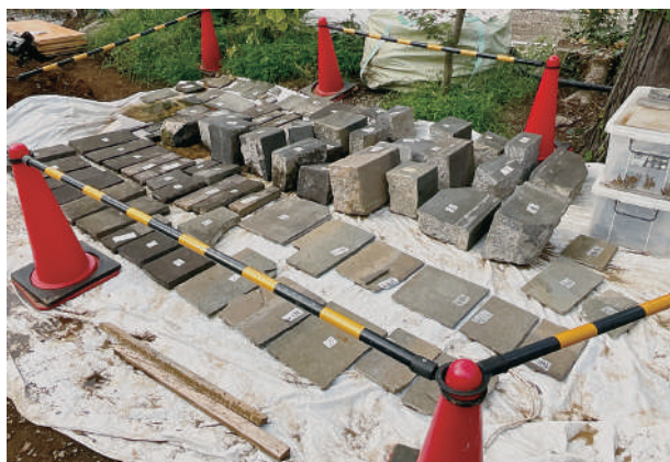
17 正門袖壁石材保管状況
