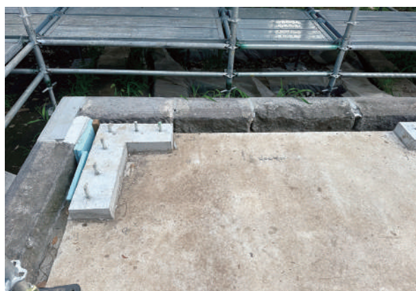
6 外周部の延石据付と耐圧板
