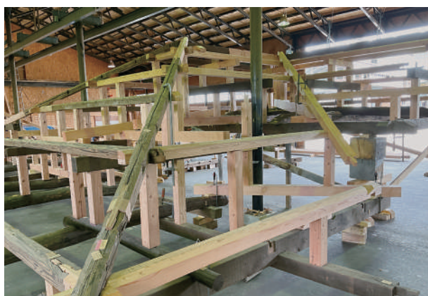
2 福井工場での仮組（応接室北西部分）
