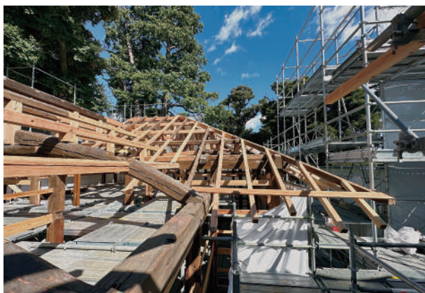
7 建方完了（玄関部分）
