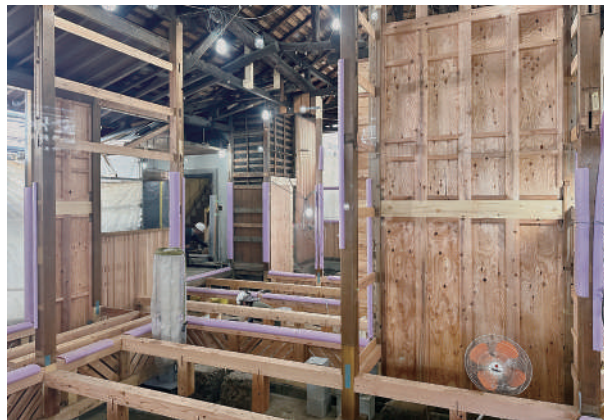
16 居間床の間部分軸部施工状況
