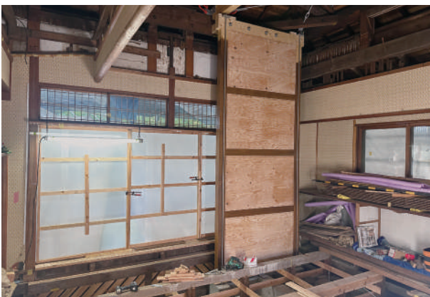
25 寝室ふかし壁施工状況
