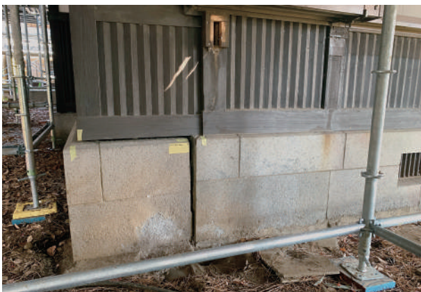
1 寝室西側施工前
