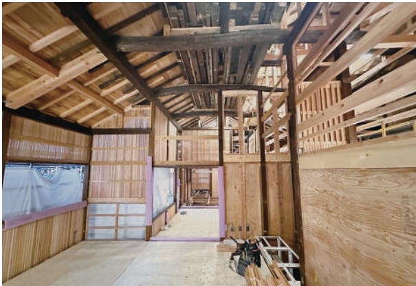
21 保管材保管状況（事務室上部）
