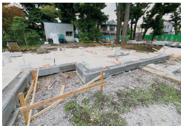
4 延石1段目据付状況
