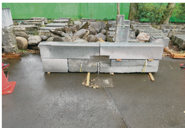
3 古材と新規材の仮組
