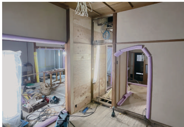
23 別棟次の間ふかし壁施工状況
