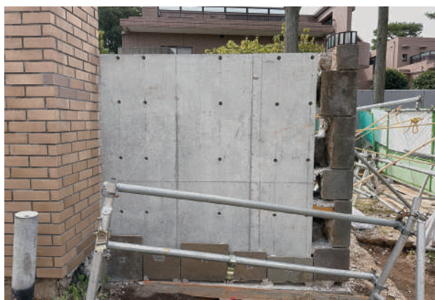
15 正門袖壁躯体施工完了
