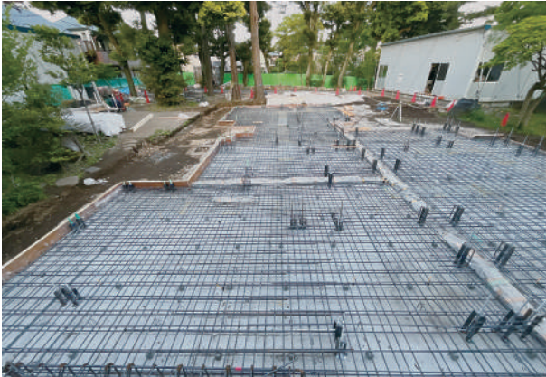
1 巣鴨棟耐圧板配筋完了
