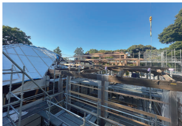
6 小屋組建方状況
