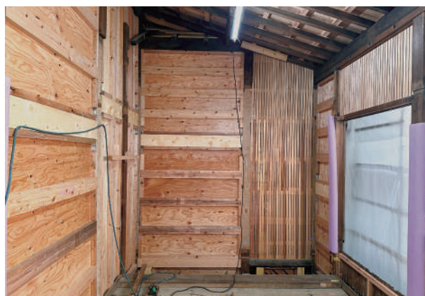
18 次ノ間軸組施工状況
