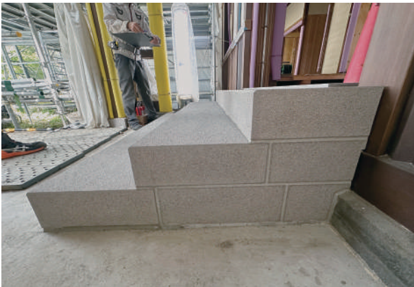
11 車寄階段石据付状況
