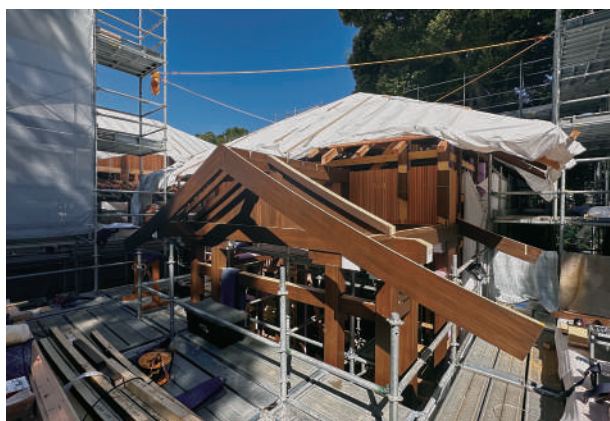
11 車寄建方状況
