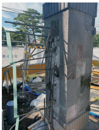
18 正門袖壁配筋と門柱への差筋状況
