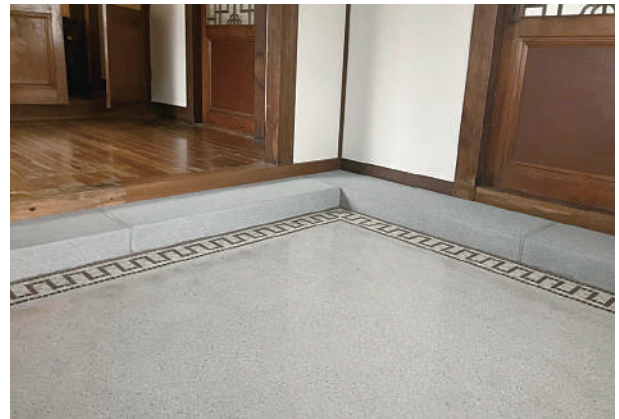
12 玄関土間式台石据付完了
