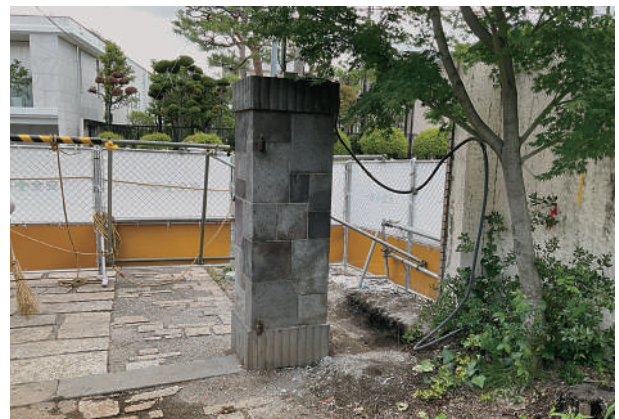
14 正門袖壁解体後
