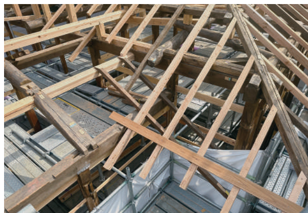
8 建方完了（玄関 - 廊下接続部分）
