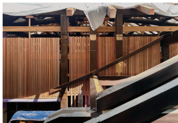
9 車寄の際垂木施工状況
