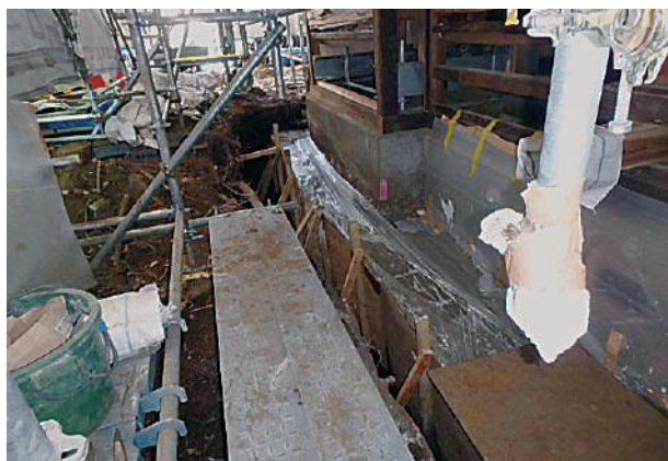
5 寝室西側改良土埋め戻し状況
