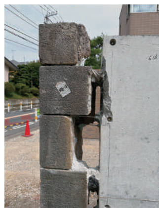
16 正門袖壁小口石と躯体との接合状況
