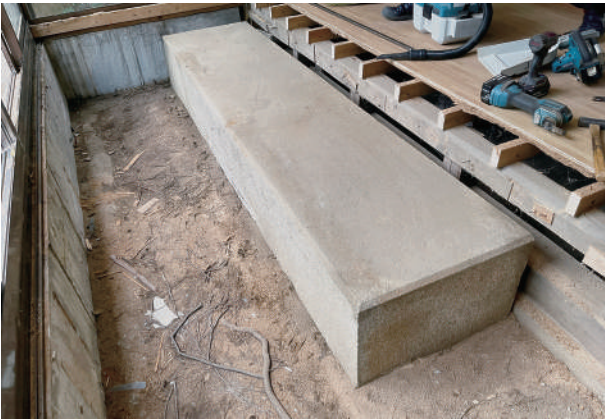
3 サンプルーム床下の靴脱ぎ石
