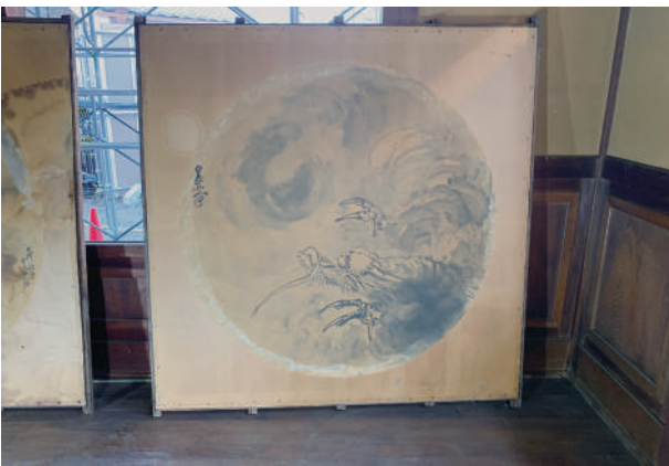
3 応接室天井材解体状況
