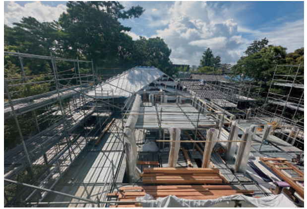
6 建方時の仮設と部材保護
