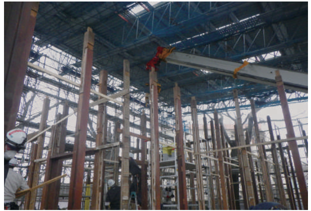
2 解体中の状況
