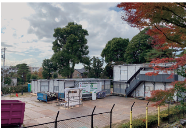
3 南側工事ヤード
