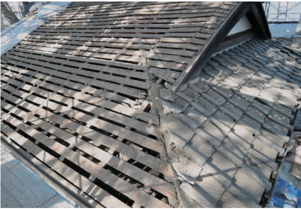
1 屋根解体状況
