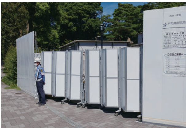
1 南側工事用ゲート
