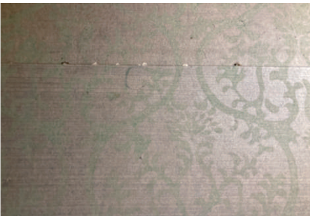
7 寝室解体時に確認された創建時壁紙
