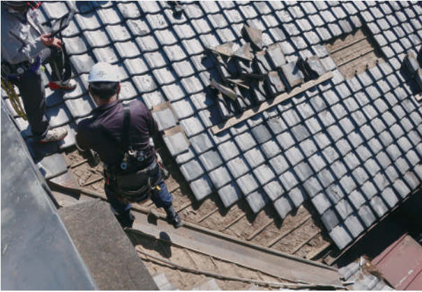
1 萩窪棟屋根解体調査
