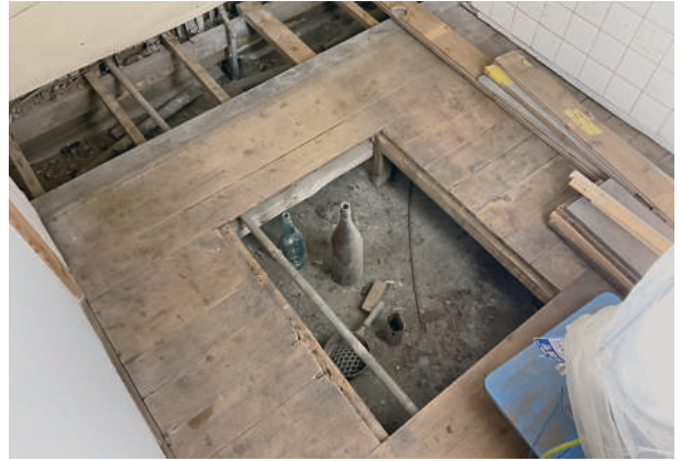
2 別棟台所解体状況
