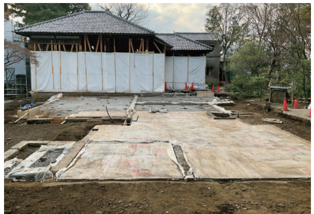
2 防湿シート敷込状況
