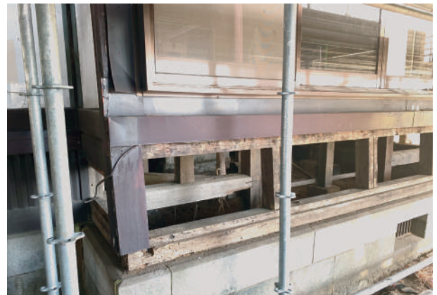
14 書斎縁側解体状況
