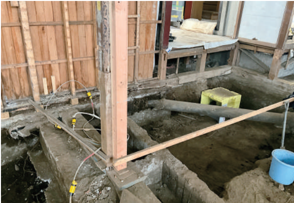
9 廊下3床下の既存配管
