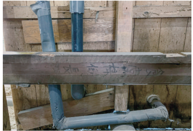
18 食堂縁側鴨居の墨書のある転用材
