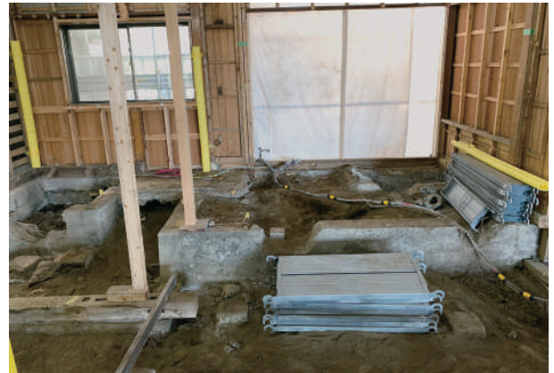
12 創建時浴室遺構（現・女性用トイレ）
