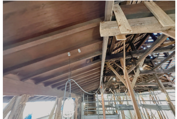
10 廊下3で現存していた化粧天井
