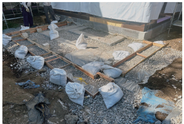
6 車寄部分の碎石敷込状況
