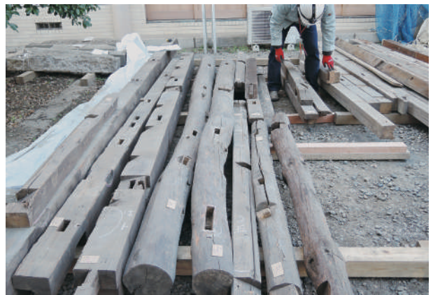
4 解体部材保管及び調査状況
