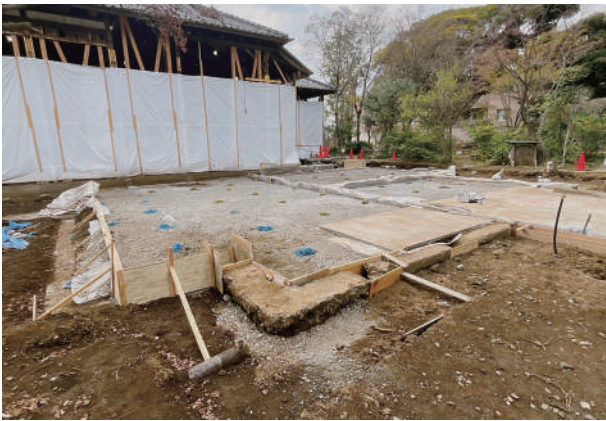
3 次ノ間南東側地盤改良状況
