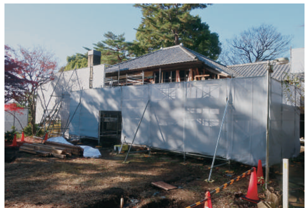
2 既存建物解体前の養生
