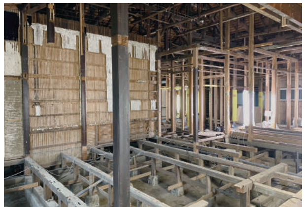
8 食堂解体状況
