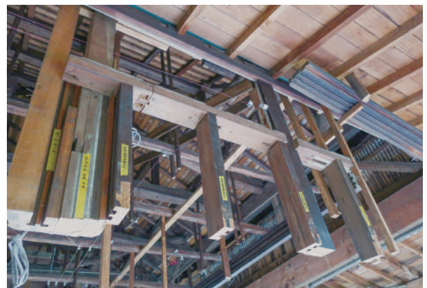
16 吊り束に転用されていた鴨居
