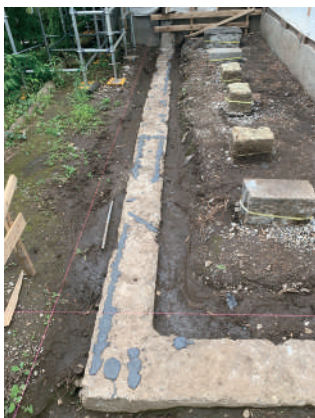
5 基礎遺構から露出する鉄筋保護状況
