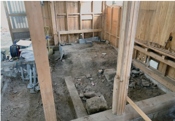
11 旧台所部分解体状況（現・事務室）
