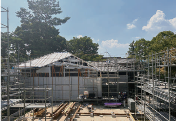
5 建方開始時の足場
