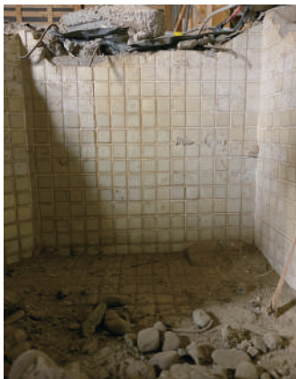
13 創建時浴槽（現・女性用トイレ）
