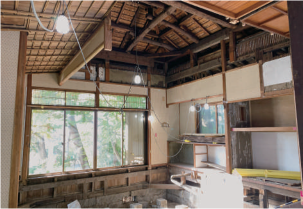
5 寝室解体状況（南東方向）
