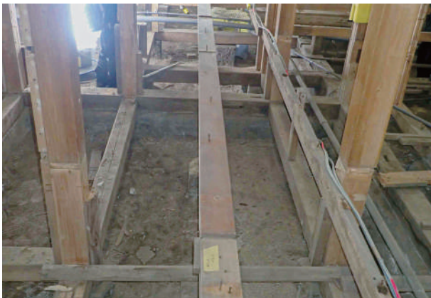
19 転用柱 b 廊下大引材（居間柱）
