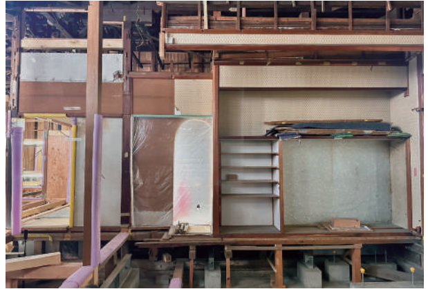
6 寝室解体状況（東面）
