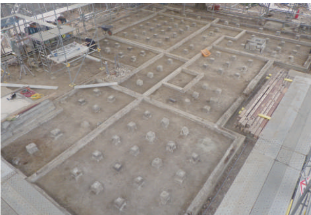
5 軸部解体後の延石状況
