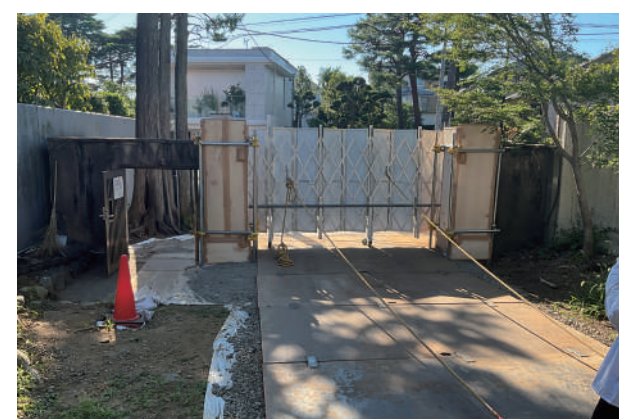
4 正門側ゲートと仮設鉄板
