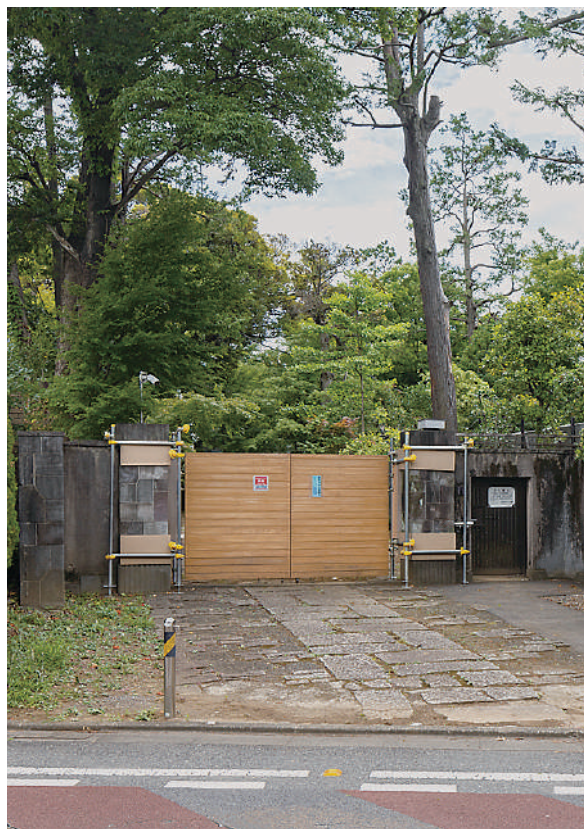
04 仮設門扉設置 令和4年7月
