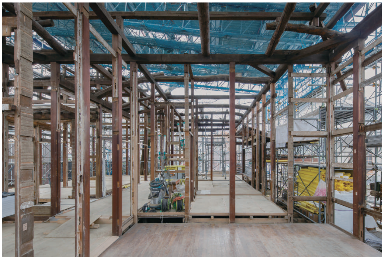
18 応接室解体状況 西面
