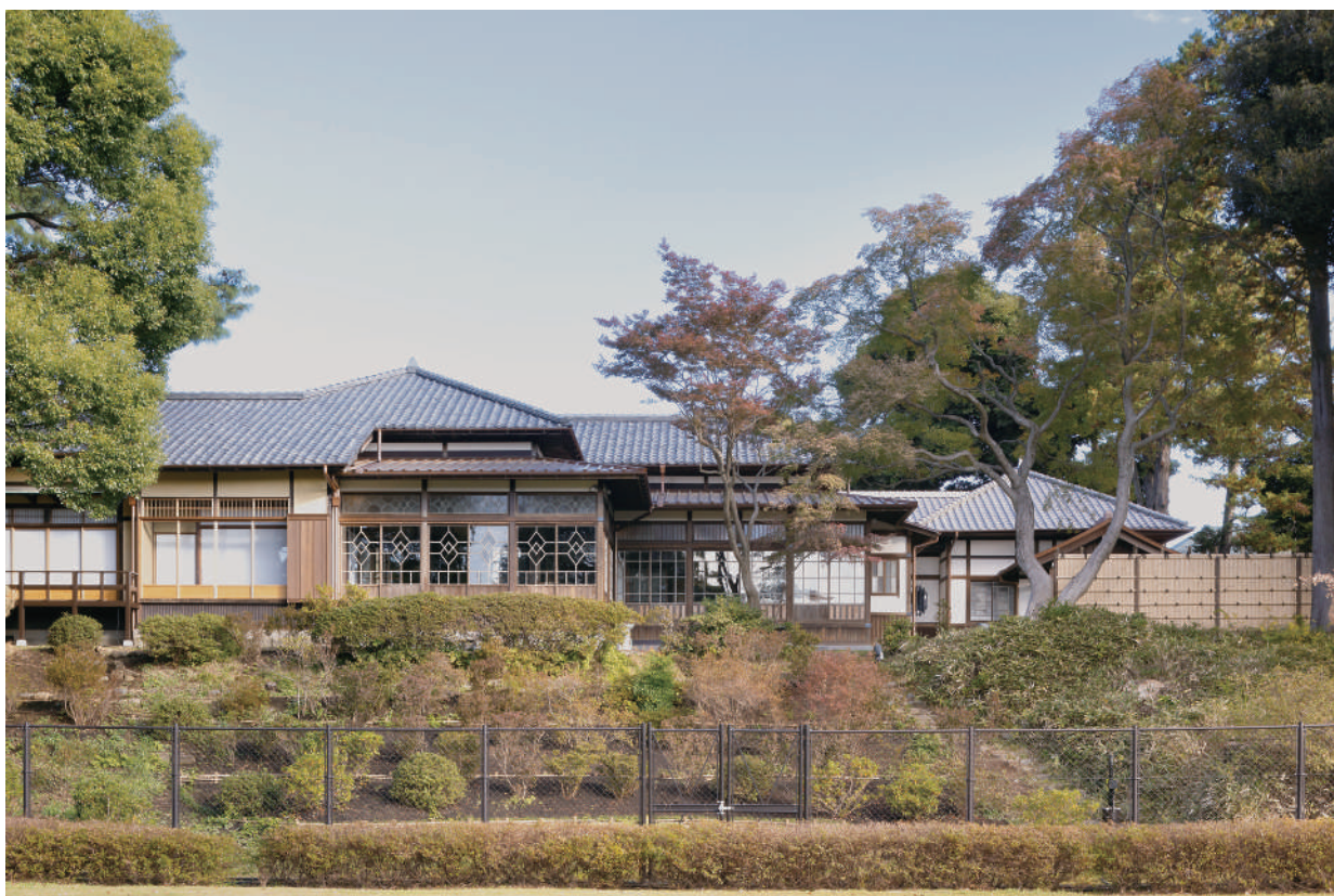
02 南側外観 竣工後
