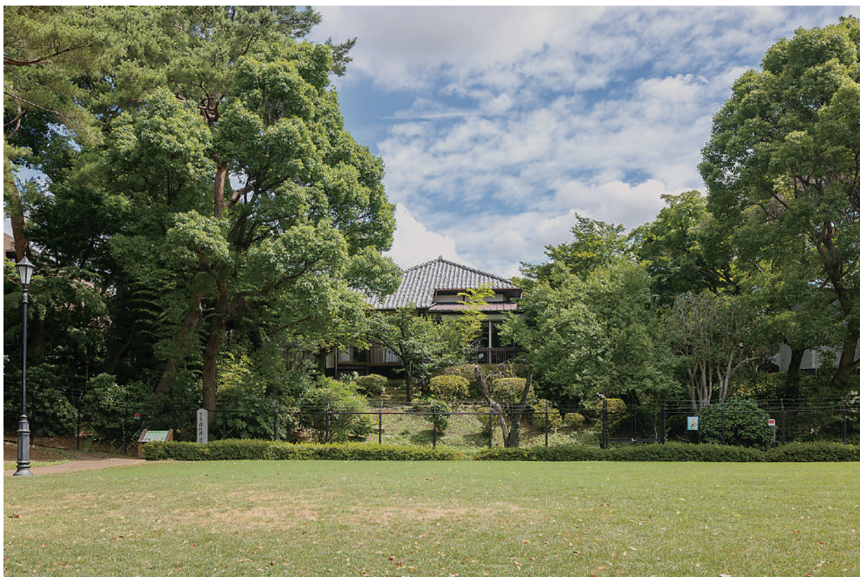
01 南側外観 着工前
