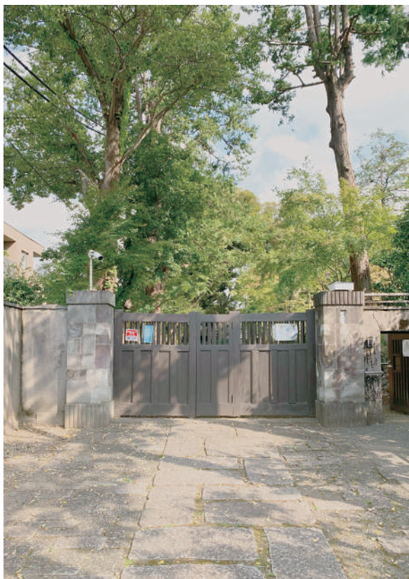
03 正門 着工前 令和2年8月
