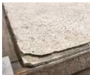
写真 7-30 天井仕上げ (繊維壁)
