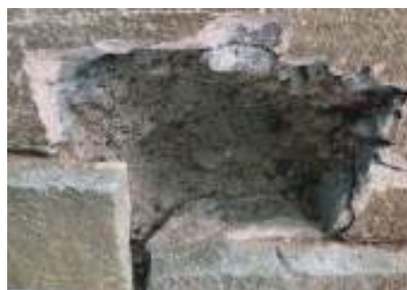
写真 7-7 正門袖塀 解体調査時の現況写真（部分拡大）
