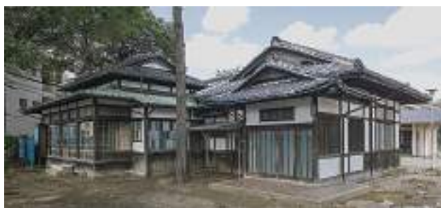
写真 7-3 巢鴨棟解体前状況（撮影 日暮雄一）
