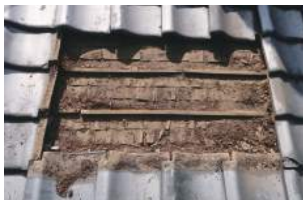
写真 7-4 別棟北面 屋根下地写真 スギのそぎ葺材
