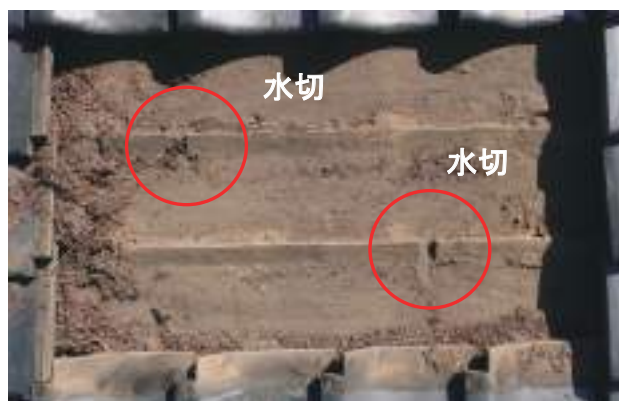
図 7-10 蔵 屋根下地写真 モルタルを加工した下地
