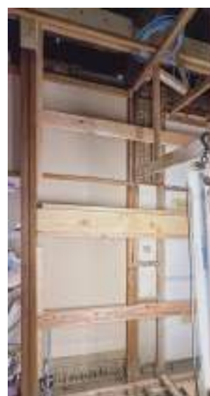
写真 7-10 別棟次の間構造 ふかし壁施工状況
