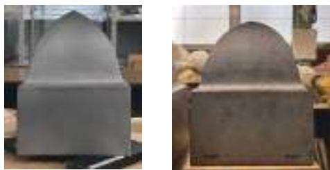
写真 7-14 鬼瓦比較 左：製作品（焼成前） 右：現存品
