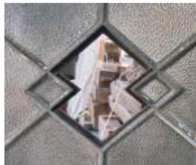
写真 7-22 欄間建具古材 ガラス取り外し状況
