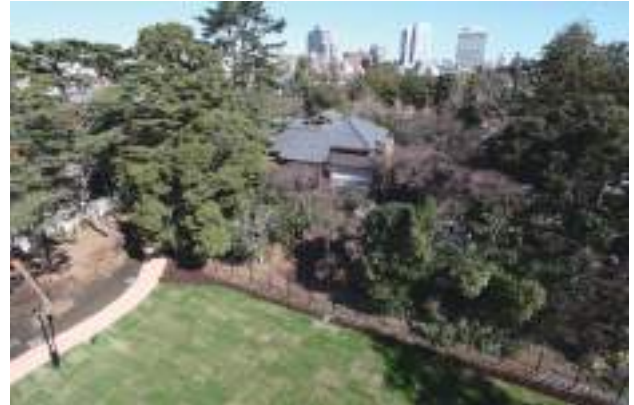
写真 7-1 着工前 荻窪棟空中写真 (平成 27 年、杉並区教育委員会撮影)
