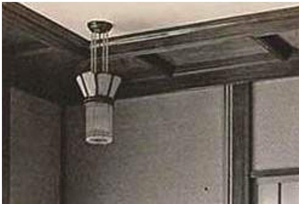
写真 7-34 創建時寝室天井（日本建築学会建築博物館蔵） 拡大写真
