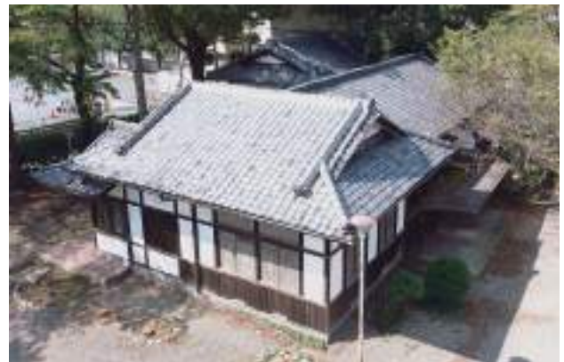
写真 7-2 巣鴨棟 解体前空中写真（撮影 日暮雄一）
