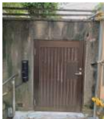
写真 7-6 正門袖塀 解体調査写真
