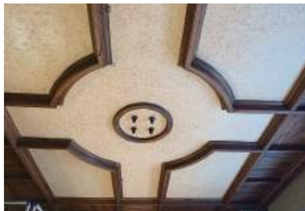
写真 7-29 巣鴨棟解体時客間天井
