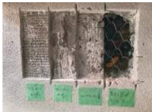
写真 7-38 蔵外部 層状解体写真
