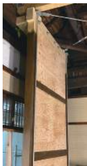
写真 7-9 寝室構造 ふかし壁施工状況
