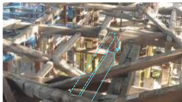
図 5-11 巢鴨棟解体時に確認された Y11 通り桁位置
