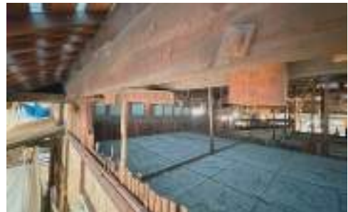
写真 5-9 書斎 当初の桁と下端の補強梁
