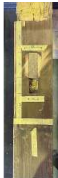
か一柱 庇腕木痕跡
