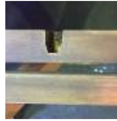
図 5-22 旧女中部屋天井 棹縁材の痕跡
