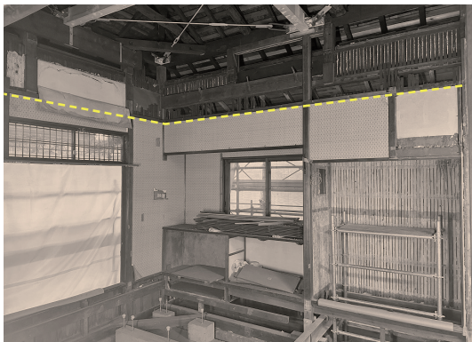
図 5-27 寝室解体時写真 点線は近衛文麿居住期の天井位置
