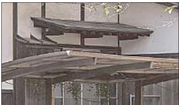
写真 5-2 巣鴨棟の女中部屋庇（撮影 日暮雄一）
