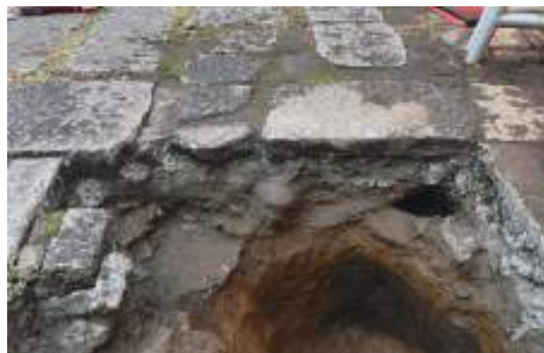
写真 3-7 石畳の基本的な構造（北から）
