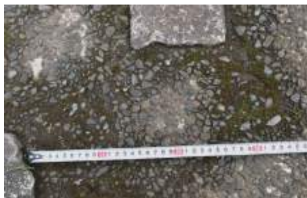
写真 3-8 石畳の洗い出し舗装
