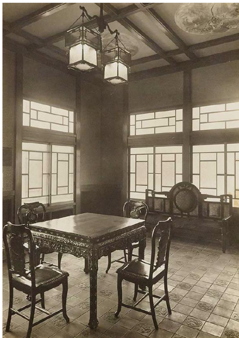
竣工写真（応接間） 昭和2年（1927）頃 日本建築学会建築博物館蔵
