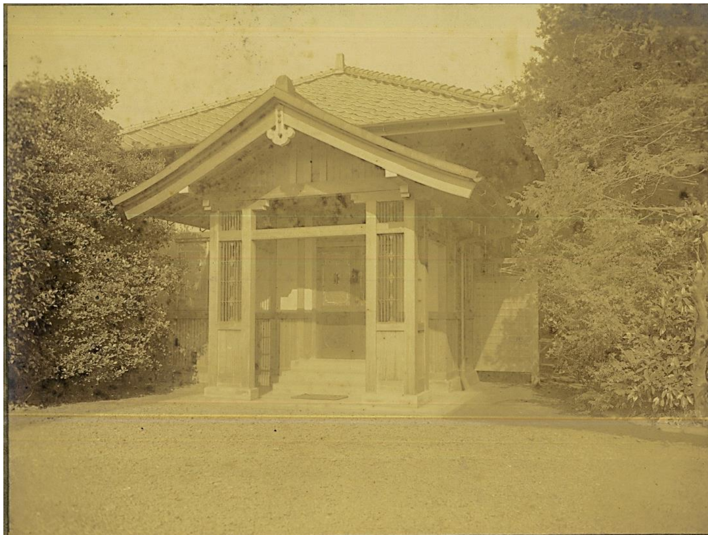
竣工写真（玄関） 昭和2年（1927）頃 個人所蔵
