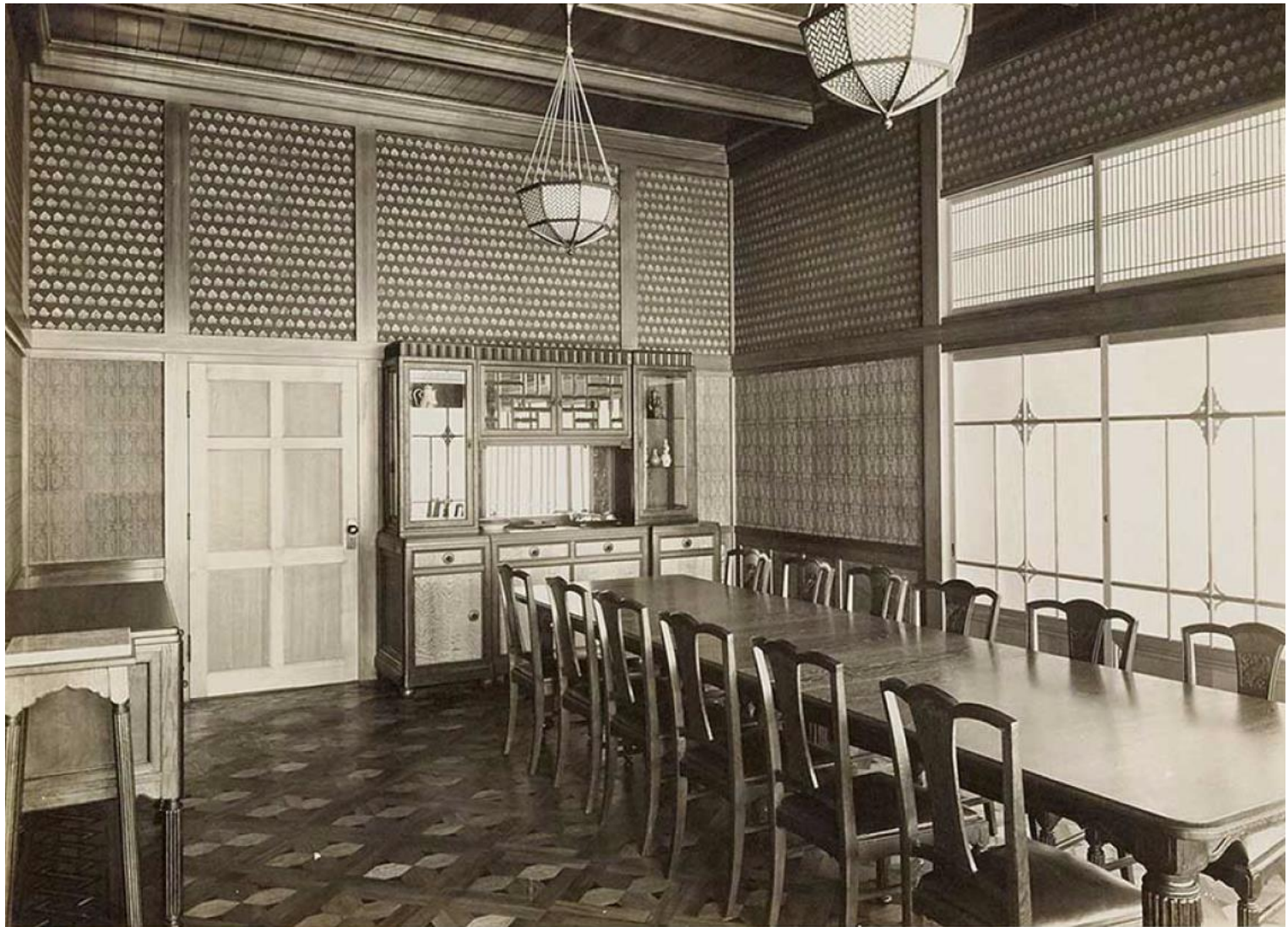
竣工写真（食堂） 昭和2年（1927）頃 日本建築学会建築博物館蔵
