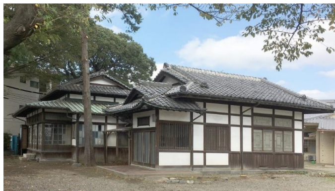
移築部分 外観
