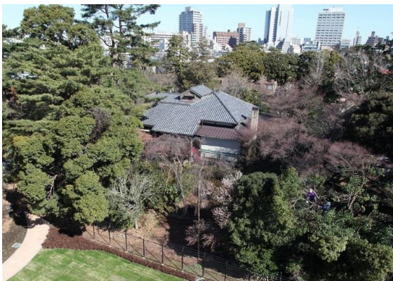
現在の荻外荘 中央は居住棟部分
