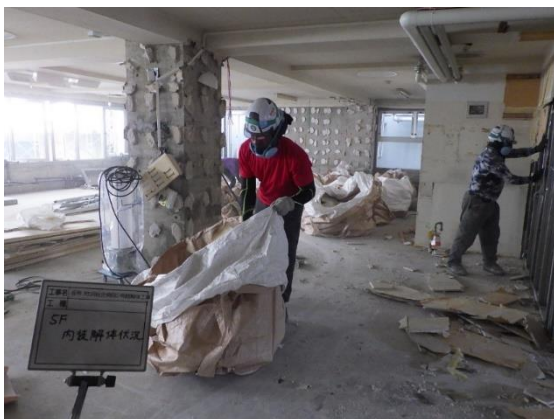
▲内装解体(参考写真)
