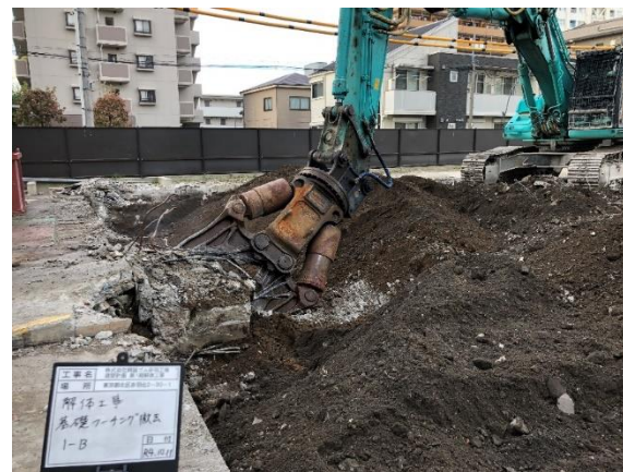
▲重機基礎解体(参考写真)
