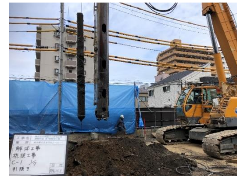
▲杭引抜き状況(参考写真)
