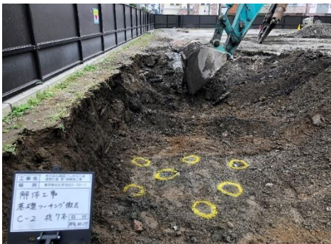
▲杭頭頭出し状況(参考写真)
