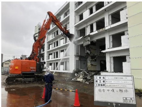
▲散水状況(参考写真)
