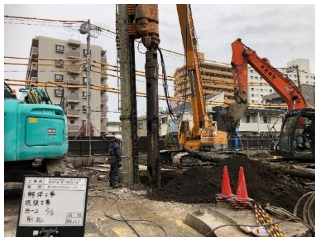
▲杭削孔状況(参考写真)
