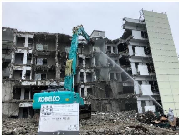
▲重機上屋解体(参考写真)
