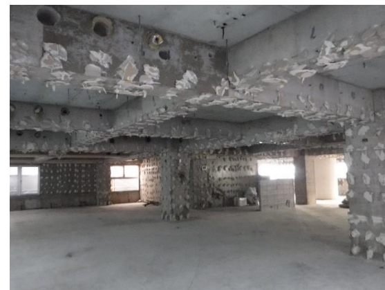
▲内装解体(参考写真)
