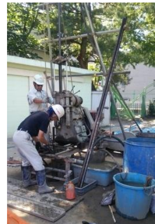
夏休みに実施した地盤調査（プール脇）
