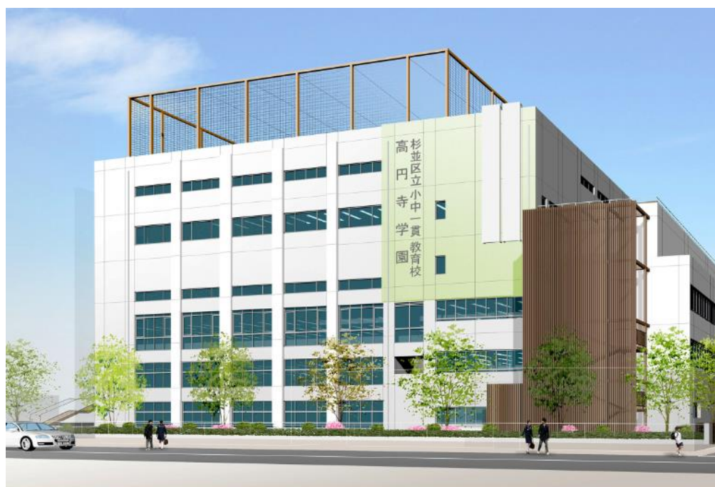
南側（中央線側）から見た校舎
