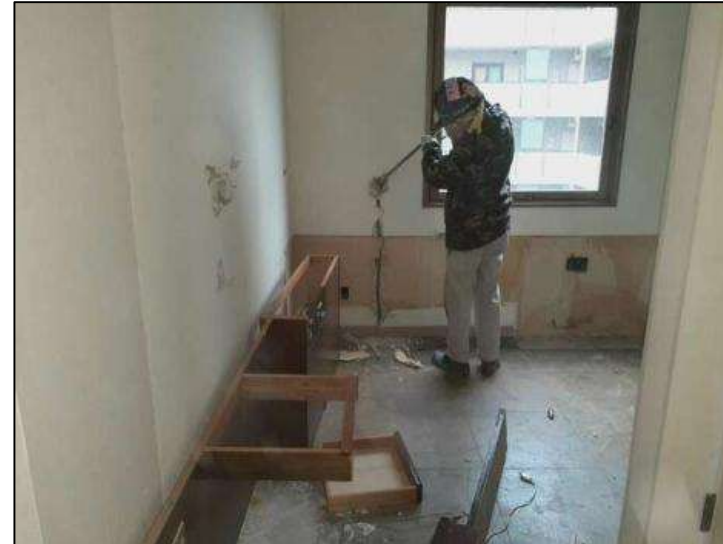
内装解体(参考写真)
