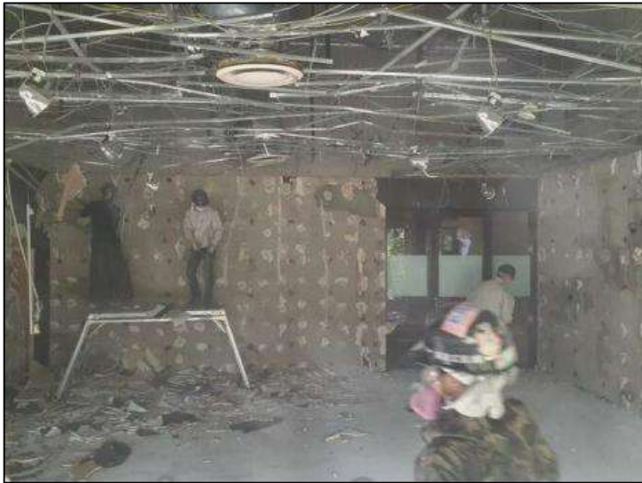
内装解体(参考写真)
