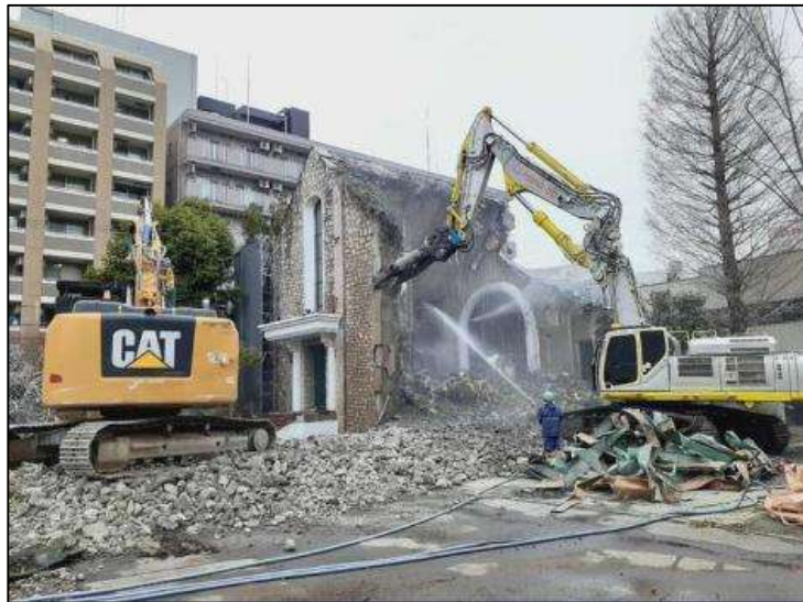
重機上屋解体(参考写真)
