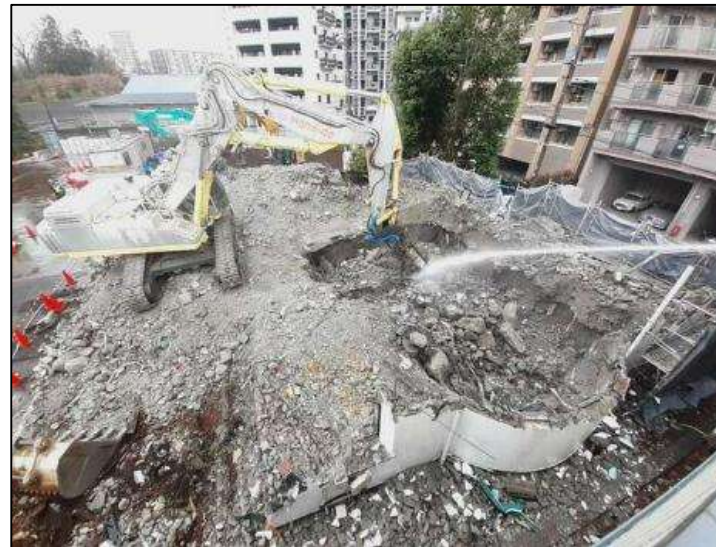
重機基礎解体(参考写真)
