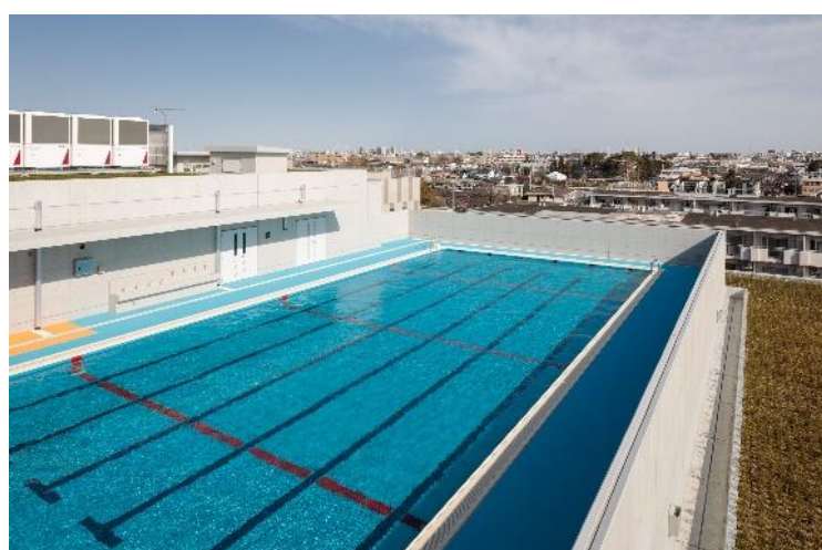
▲4階に設置したプール
