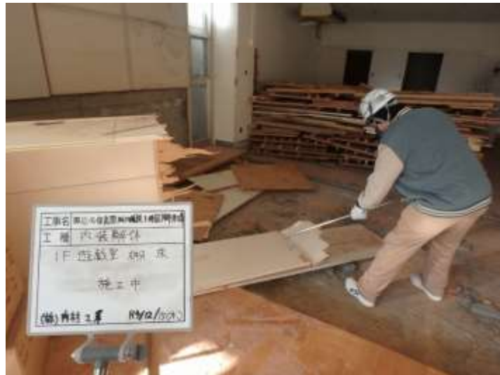
▲内装解体(参考写真)
