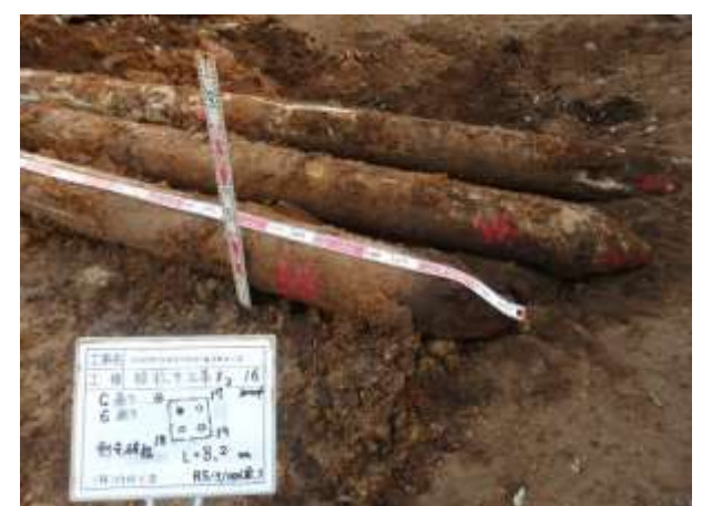
▲既存杭引抜き(参考写真)
