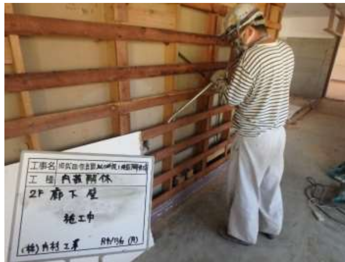
▲内装解体(参考写真)
