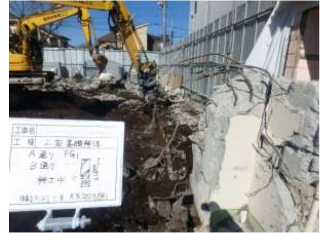
▲基礎解体参考写真)
