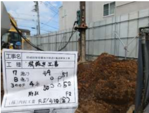
▲既存杭引抜き(参考写真)
