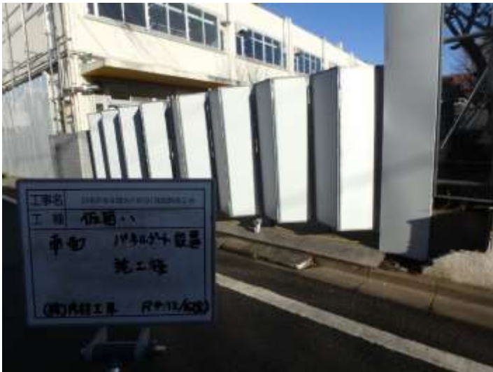
▲仮設ゲート(参考写真)
