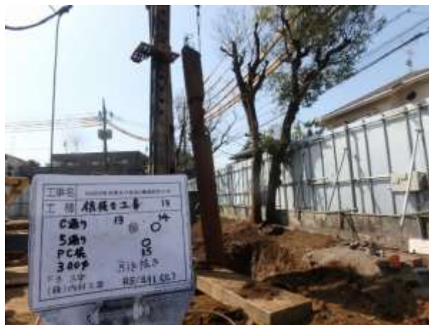
▲既存杭引抜き(参考写真)
