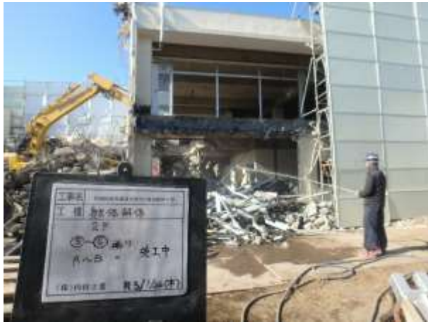
▲散水状況(参考写真)
