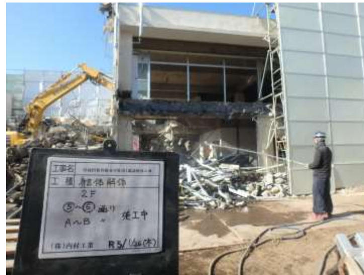
▲重機解体(参考写真)
