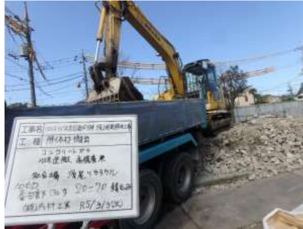
▲ガラ搬出状況(参考写真)
