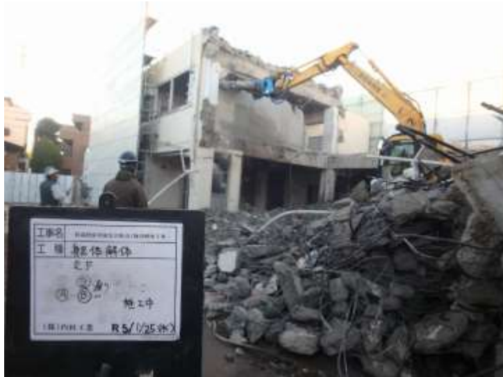
▲重機解体(参考写真)
