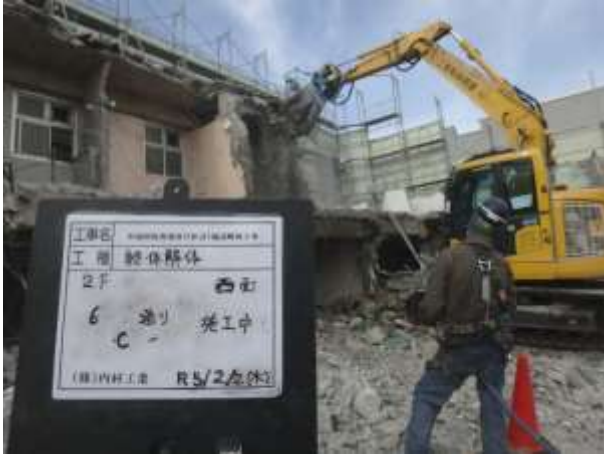
▲散水状況(参考写真)
