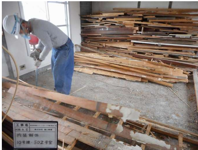
▲内装解体(参考写真)
