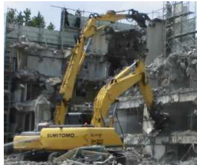
▲重機解体(参考写真)
