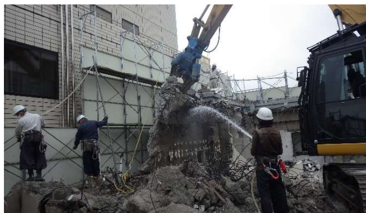
▲散水状況(参考写真)
