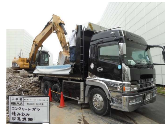
▲ガラ搬出状況(参考写真)
