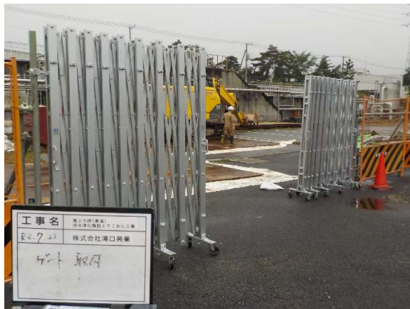
▲仮設ゲート(参考写真)
