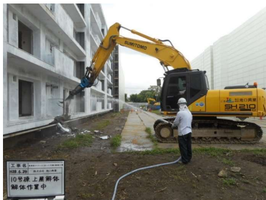
▲散水状況(参考写真)
