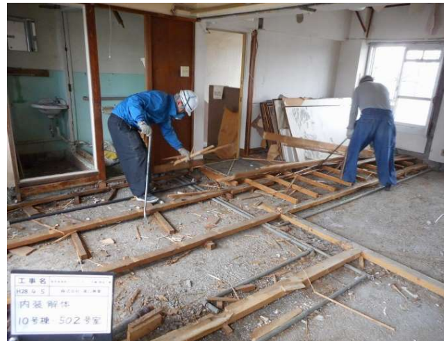
▲内装解体(参考写真)
