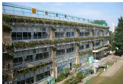
既存樹木と調和した壁面緑化と庇の設置などの改修（杉並第七小学校）
