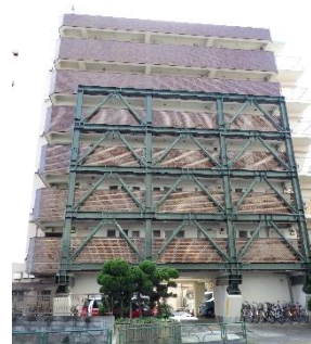
マンションの耐震改修事例
