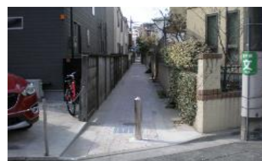
旧水路敷の整備例
