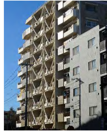
マンションの耐震改修事例
