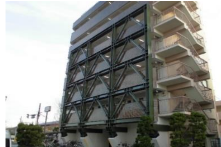
フレーム補強の事例
