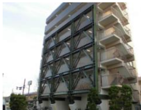
フレーム補強の事例
