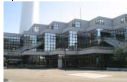
高井戸地域区民センター 1 階 (高井戸東 3-7)
