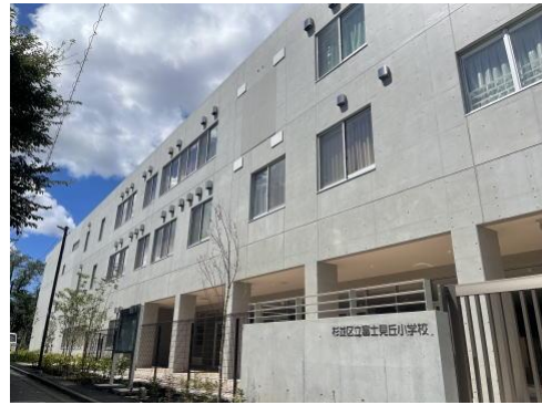
富士見丘小学校 2023.7 校舎新築
