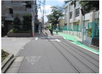
▲旧若杉小周辺の拡幅整備事例
