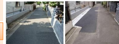
整備前 整備後 ▲狭あい道路拡幅整備の事例
