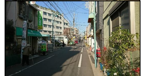
⑥病院周辺道路 ・病院への車両等通行 【写真上】病院西側道路 (幅員:3.7~5.5m) 【写真下】病院東側道路㊪ (幅員:約6.4m)
