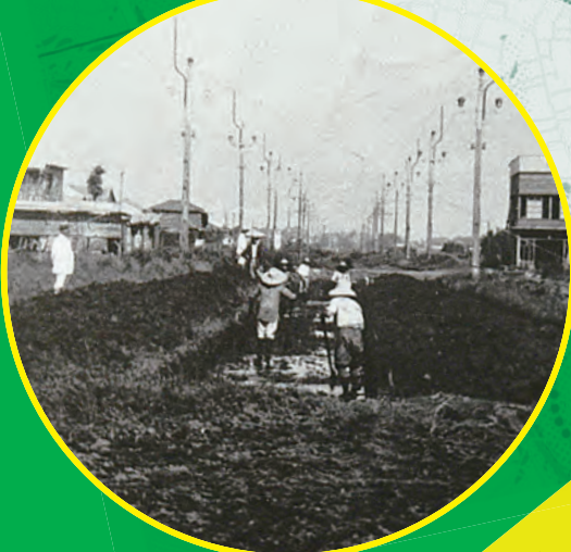
改修工事中の桃園川 (大正13年)
