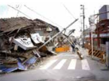
■阪神・淡路大震災における道路沿道の建物倒壊状況
