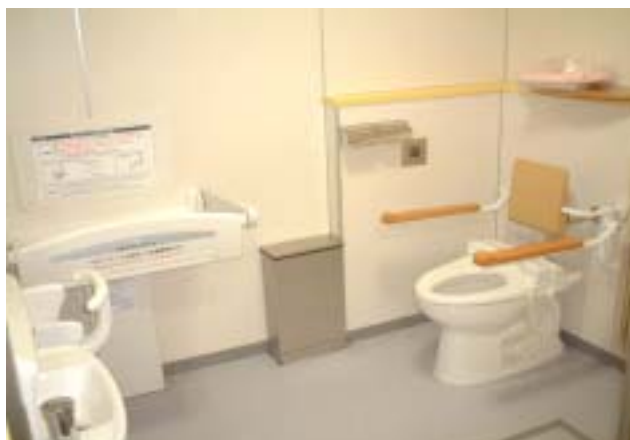
中央図書館のトイレを、身障者などの方も利用できるように改修
