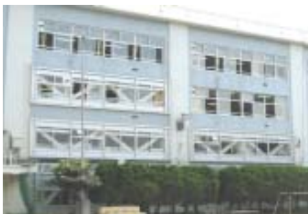
西宮中学校耐震補強（窓内にあるW型のものが耐震補強鉄骨ブレース 筋交い）
