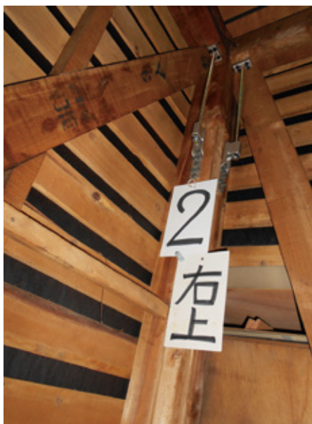
木造住宅の耐震補強例②
