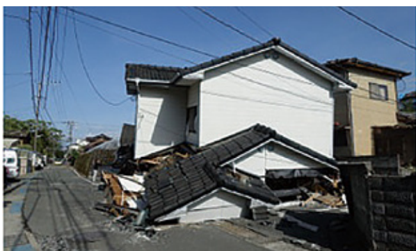
熊本地震被害状況①
