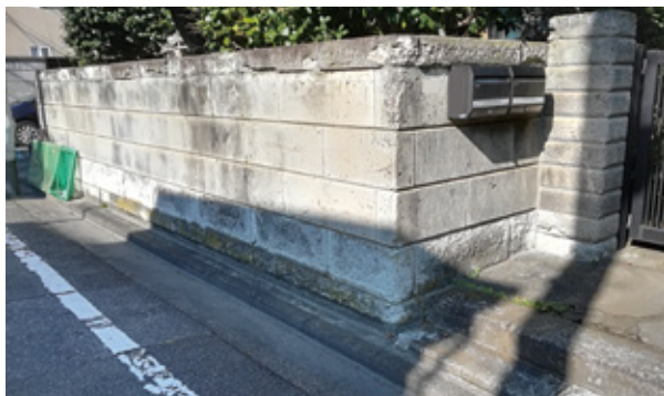
ブロック塀等改修工事前
