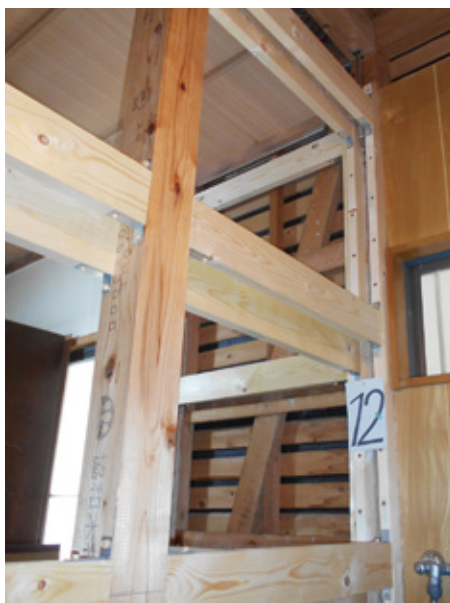
木造住宅の耐震補強例①
