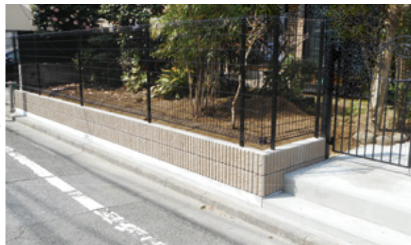
ブロック塀等改修工事後
