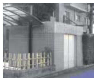
建物外壁と同一にデザインしたゴミ置き場の建物
