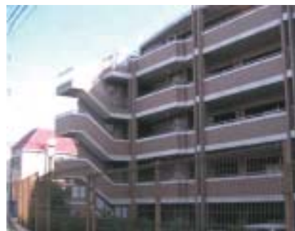
外階段、外廊下、バルコニーを一体的に見せるデザイン
