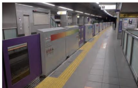
ホームドア設置例 (京王井の頭線渋谷駅)
