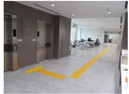
視覚障害者用誘導ブロック (阿佐谷地域区民センター)
