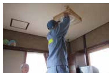
蛍光灯の交換作業
