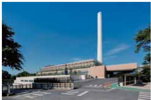
すぎなみ 杉並清掃工場
