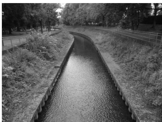
緩傾斜護岸 (Z5 成田上橋)
