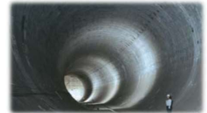
②環状七号線地下広域調節池（石神井川区間） 環状七号線、目黒通り（練馬区・中野区） 規模：約681,000m 3
