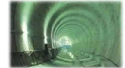
⑧谷沢川分水路 環状八号線、玉川通り等（世田谷区） 規模：約3.2km
