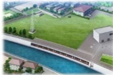
⑥境川木曾東調節池 境川クリンツェル跡地（町田市） 規模：約49,000m 3
