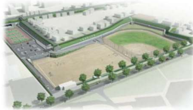
⑤野川大沢調節池 調布基地跡地（三鷹市） 規模：約68,000m 3
