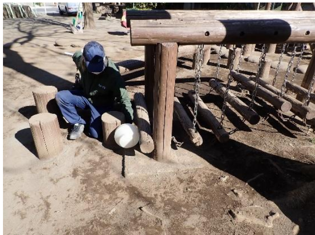
▲遊具点検の様子
