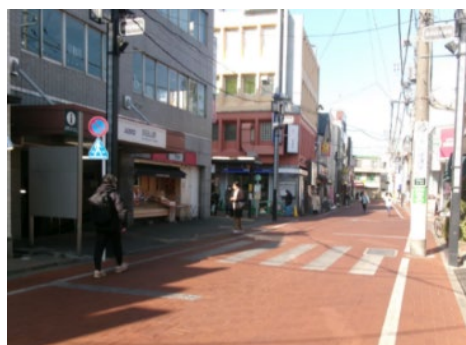
カラー舗装改修工事
