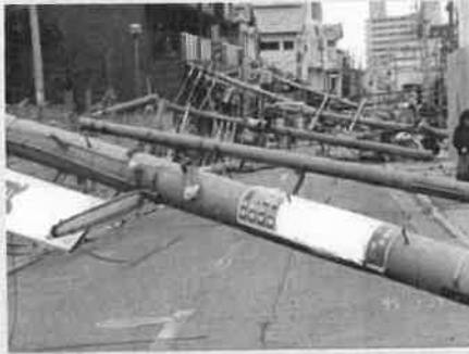
阪神・淡路大地震による電柱倒壊現場 (平成7年1月17日 出典：兵庫県)
