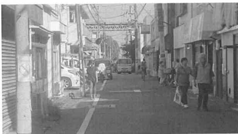
事業区間の中間付近の様子
