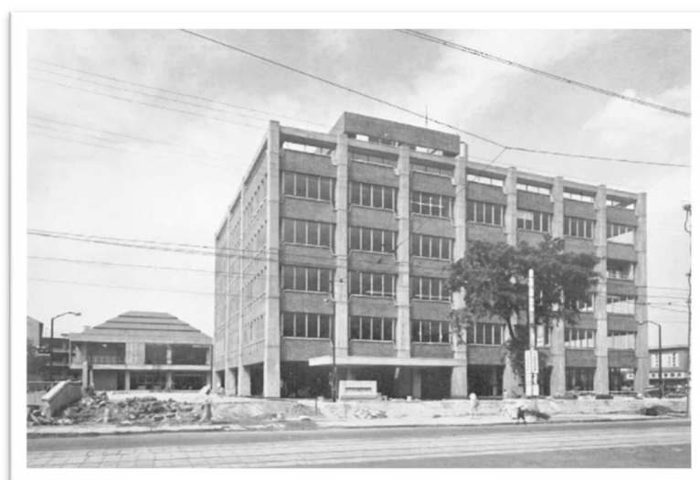
第一庁舎及び第二庁舎南側写真 杉並区役所庁舎落成記念誌（昭和38年（1963年）7月）より
