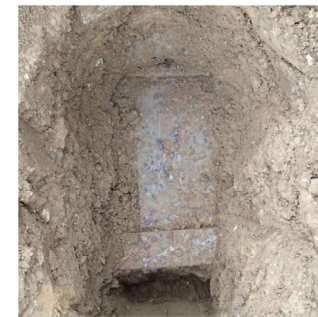
地中壁位置現地確認状況(測量)
