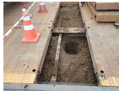
誤ったトンネル計画高さで設計した地中壁と切削断面の位置
