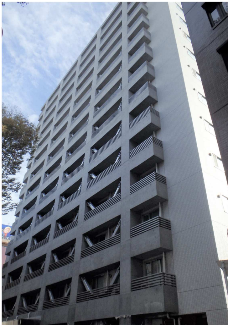
耐震改修工事を行った分譲マンション
