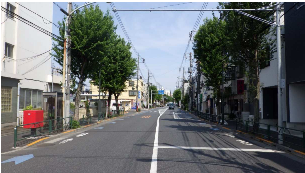
一般緊急輸送道路（早稲田通り）
