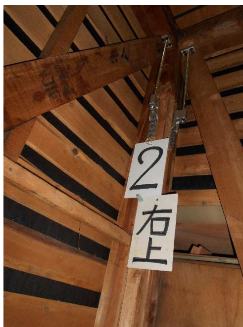
木造住宅の耐震補強例
