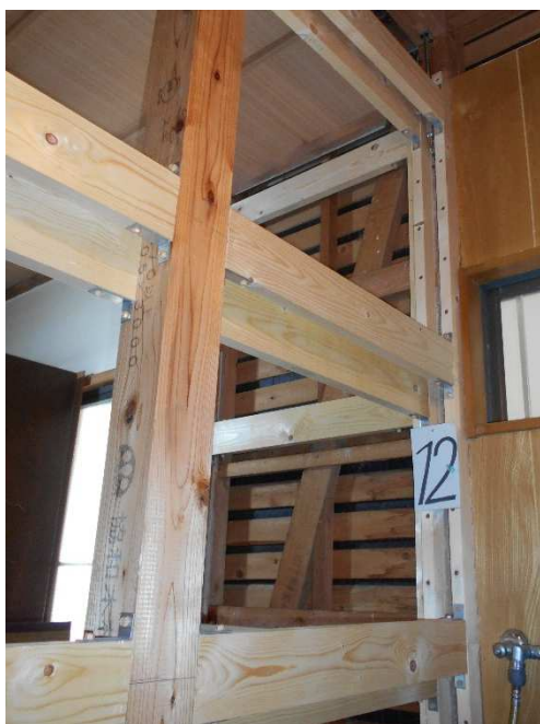
木造住宅の耐震補強例
