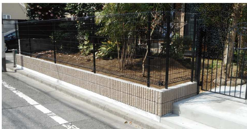
ブロック塀等施工前後
