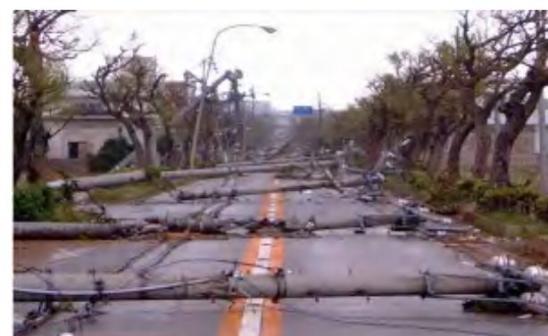
沖縄県宮古島市 出典：国土交通省 災害時に電柱倒壊で通行障害の恐れ
