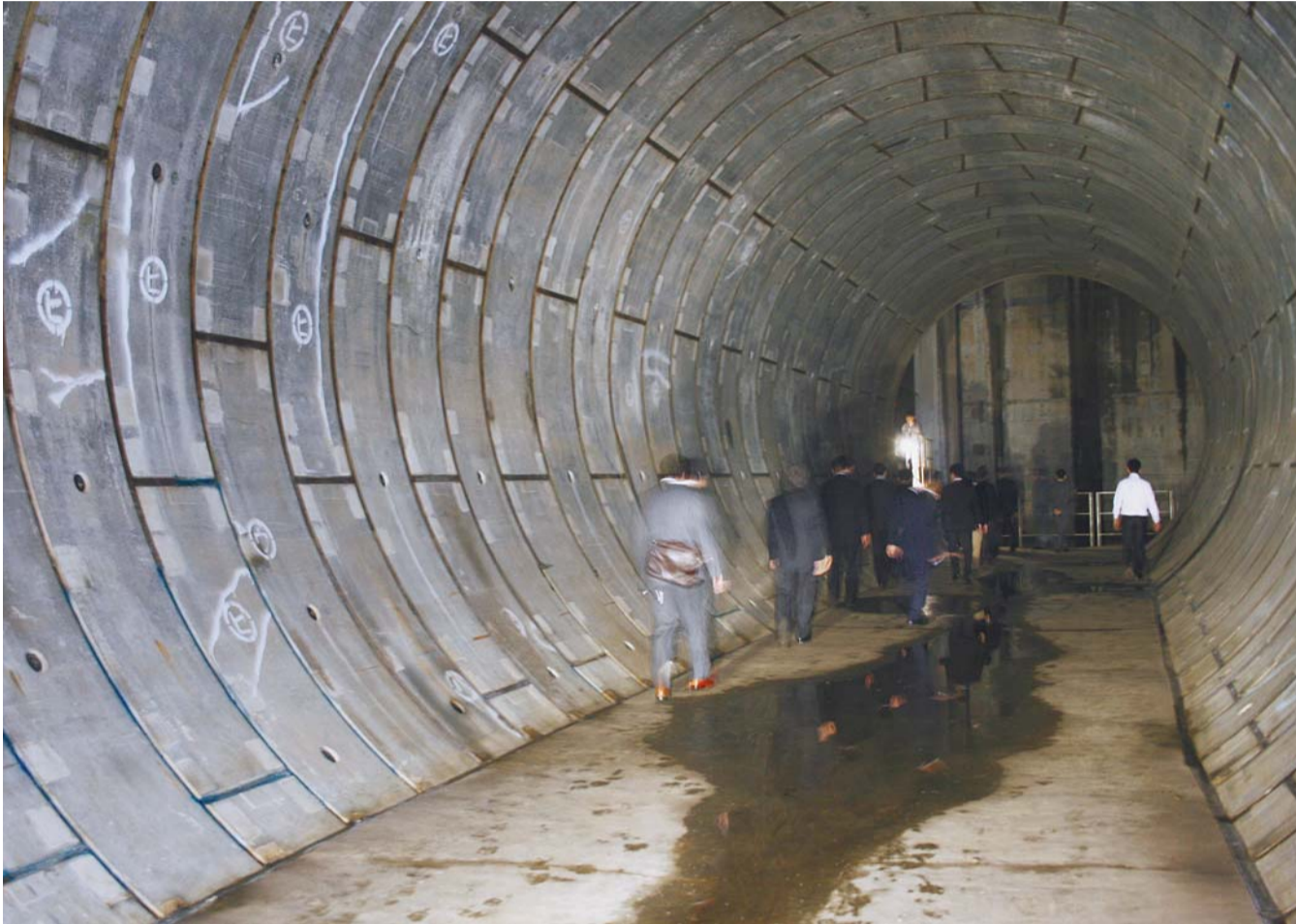
集中豪雨や台風による水害から区民を守る神田川・環状七号線地下調節池の善福寺川取水施設（東京都の施設）。他に神田川取水施設、妙正寺川取水施設がある。環状七号線の道路下にある延長4.5km、内径12.5mのトンネルには、善福寺川、神田川、妙正寺川の洪水約54万m 3 を貯留。（災害対策特別委員会視察）
