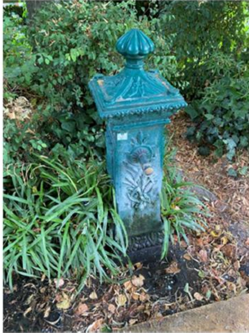
散歩道にも水道が設置されている
