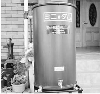
▲小型雨水貯留槽
