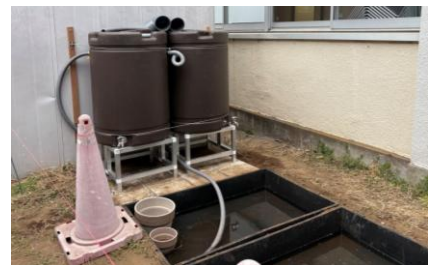
雨水タンクとビオトープ
