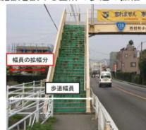
国道139号（山梨県西桂町）
